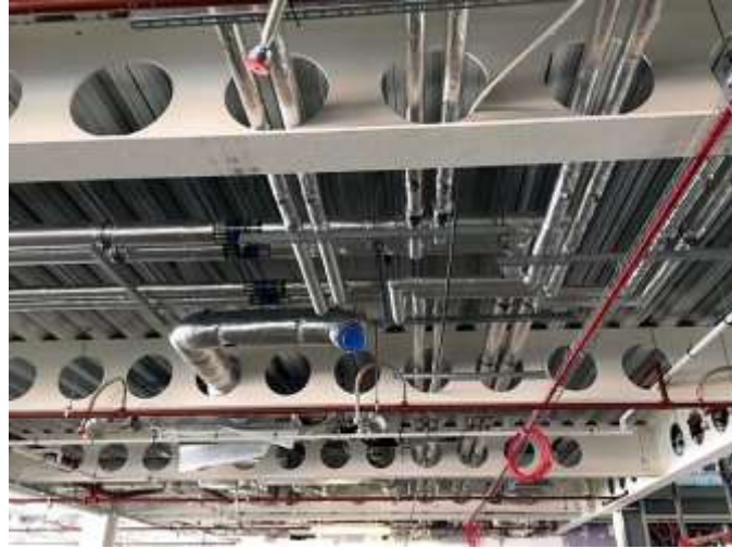
Şekil 2.23. Çelik Kirişlerinde Hizmetler için Oluşturulan Açıklıklar
