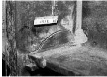
Şekil 1.4. Kolon Başığı Kırılması (FEMA, 351)
