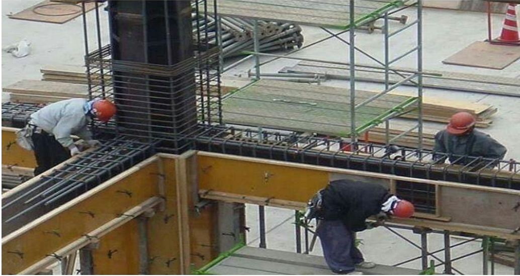
Şekil 2.9. Çelik gömme kompozit kolon-betonarme kiriş birleşimi (örnek)
