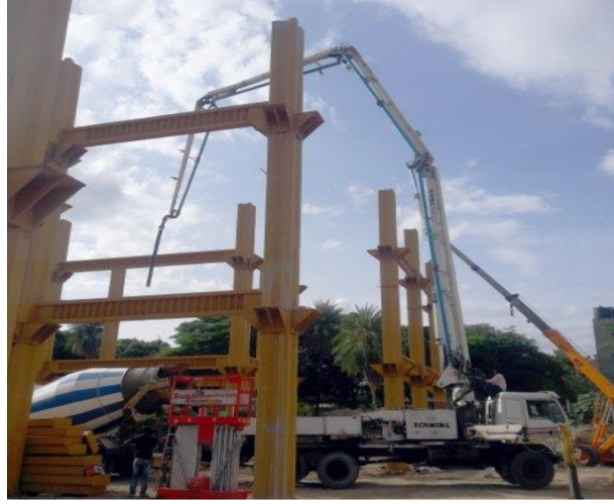
Şekil 2.10. Beton dolgulu kompozit kolon-çelik kiriş birleşimi (örnek 1)
