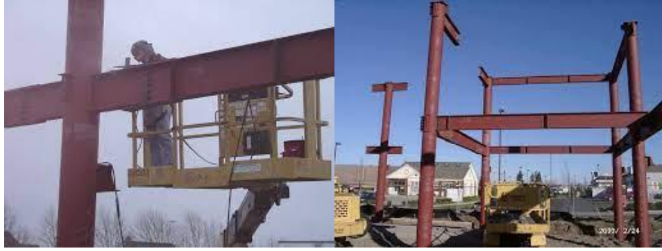
Şekil 2.11. Beton dolgulu kompozit kolon-çelik kiriş birleşimi (örnek 2)
