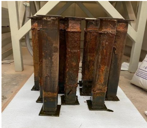
Şekil 3.25. Hızlandırılmış korozyon havuzundan çıkarılan profiller
