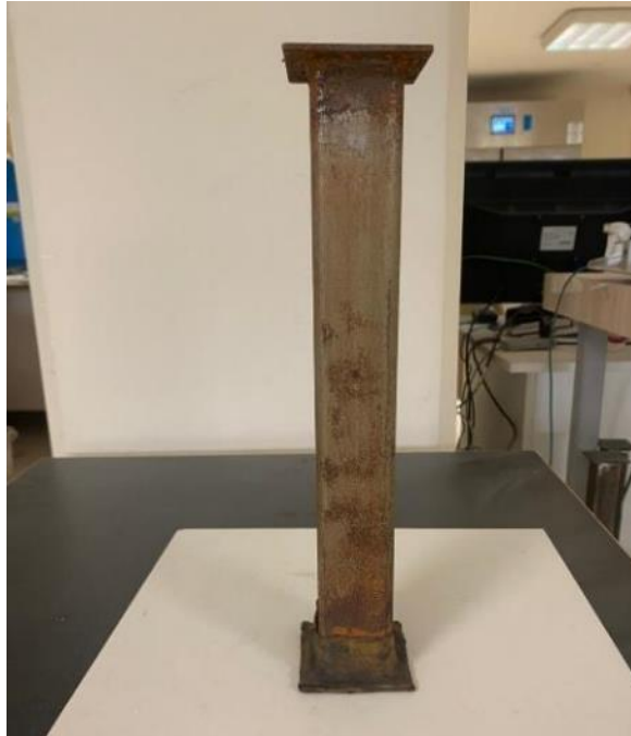
Şekil 3.4. Korozyon hasarına uğrayan profil örneği
