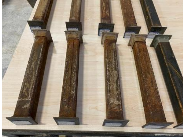
Şekil 3.29. Korozyona uğramış profillerin güçlendirilmeden öncesi
