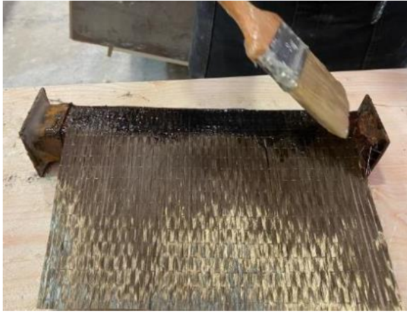
Şekil 3.32. Birinci kat güçlendirme uygulaması (BFRP)
