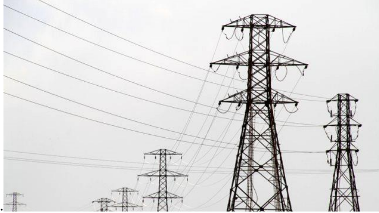
Şekil 3.5. Çok yüksek gerilim kulesi
