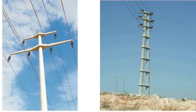
Şekil 3.3. Beton kule tipleri
