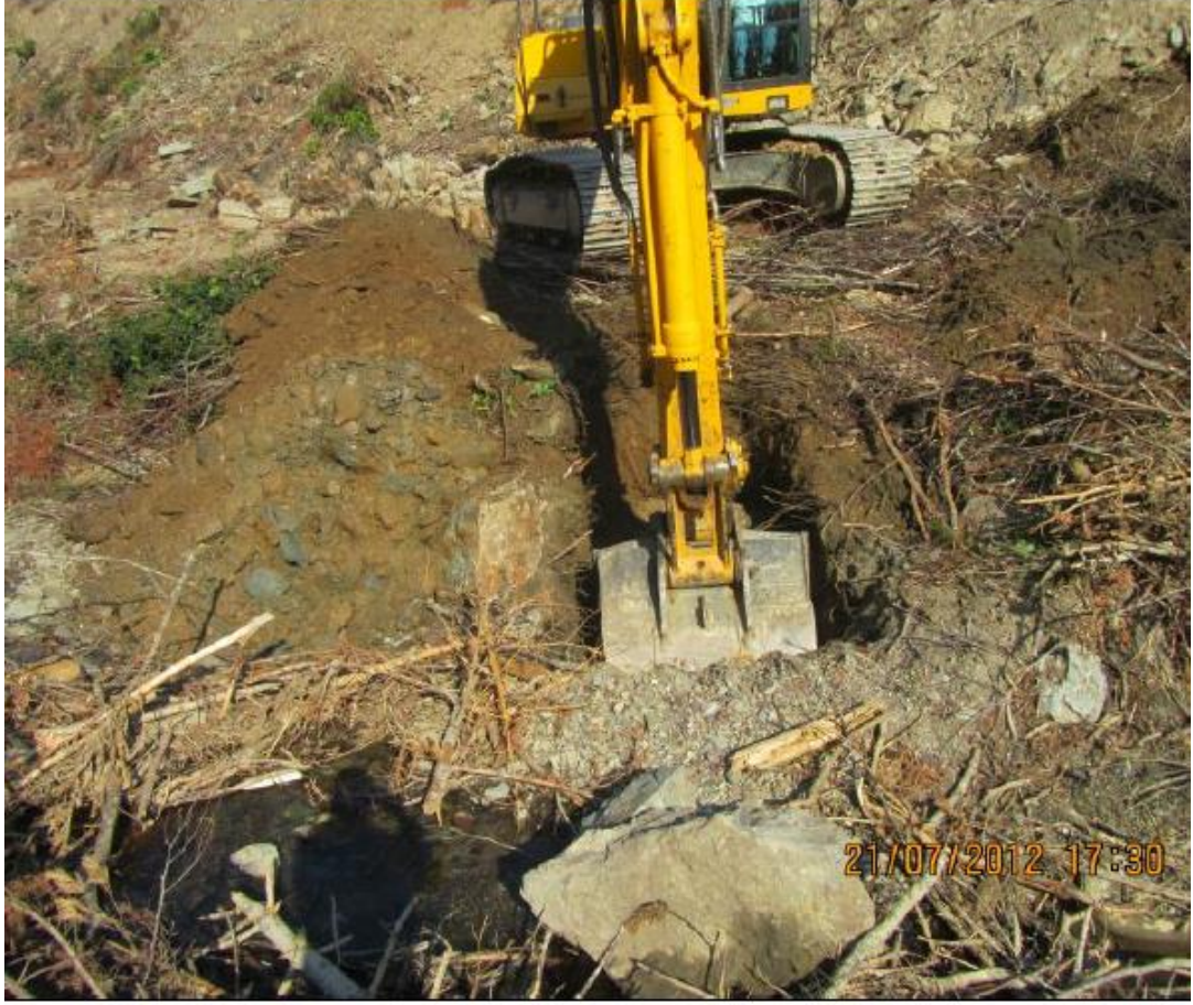
Şekil 4.7. Talvegte Alüvyon Kalınlığını Belirlemek için Açılan Araştırma Çukurunun Görünümü
