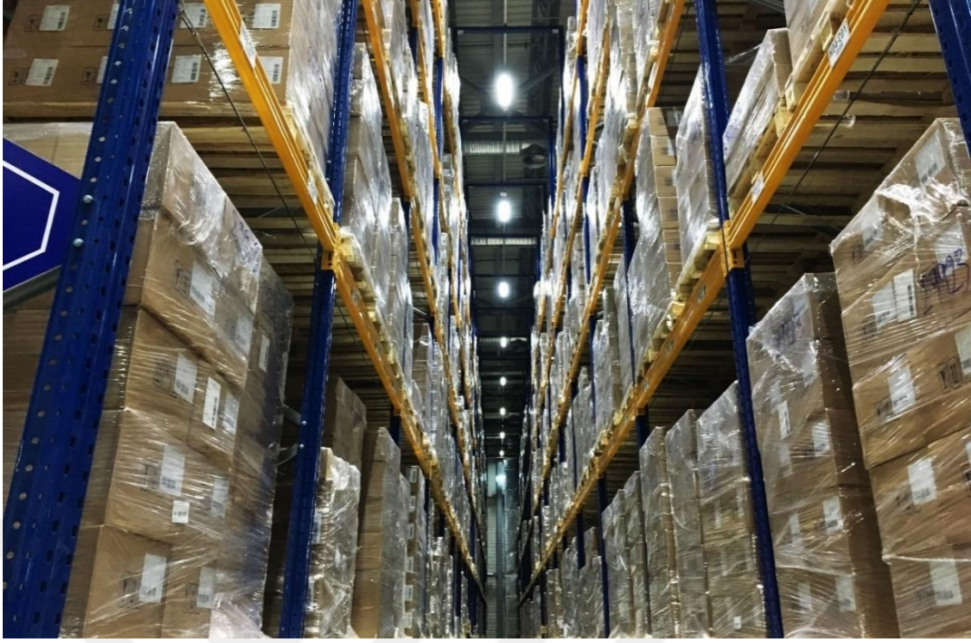
Şekil 4.5. Dar Koridor Raf Arası Yüksek Tavan Armatürlerle Aydınlatma Çalışması
