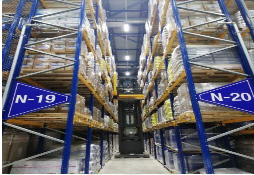
Şekil 4.3. İlaç Deposunda Yüksek Tavan Aydınlatma Uygulaması
