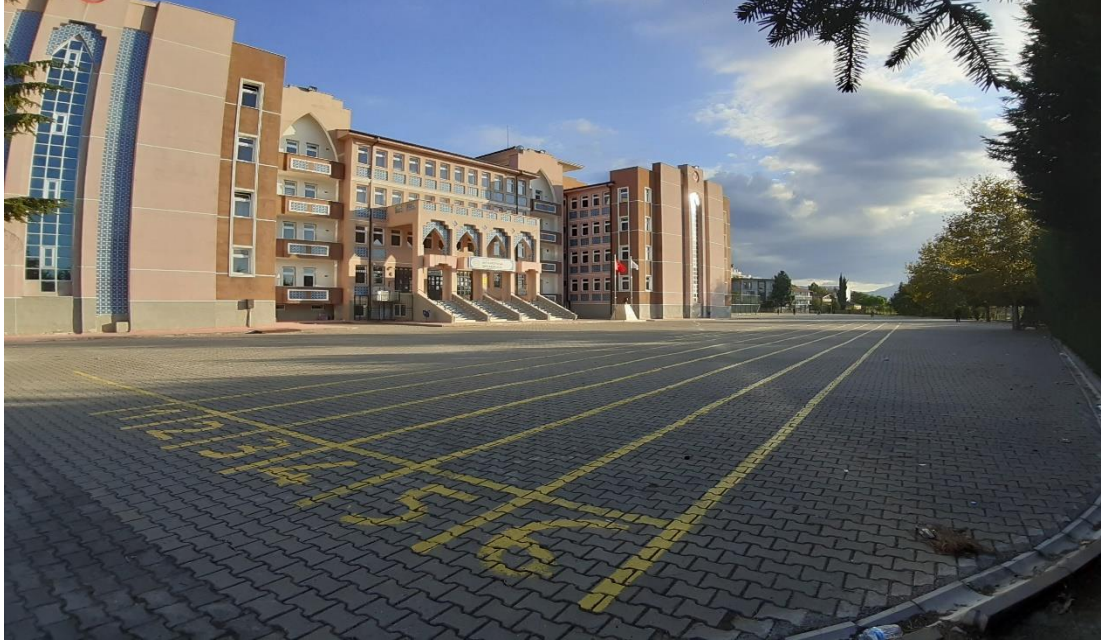
Şekil 3.203. Mithatpaşa mahallesi 21 numaralı acil durum toplanma alanı.
