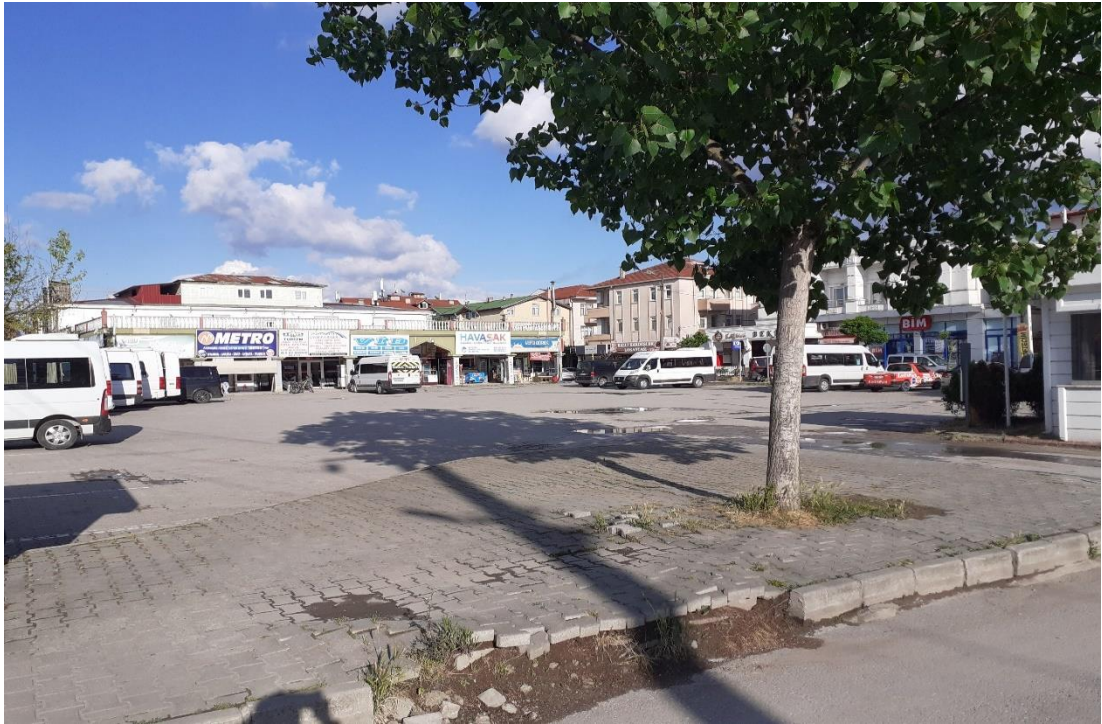
Şekil 3.34. Tekeler mahallesi 91 numaralı toplanma alanı.
