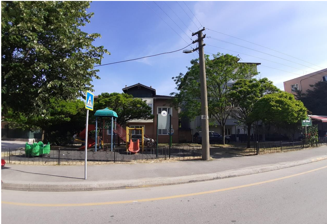
Şekil 3.149. Yenigün mahallesi 50 numaralı acil durum toplanma alanı.
