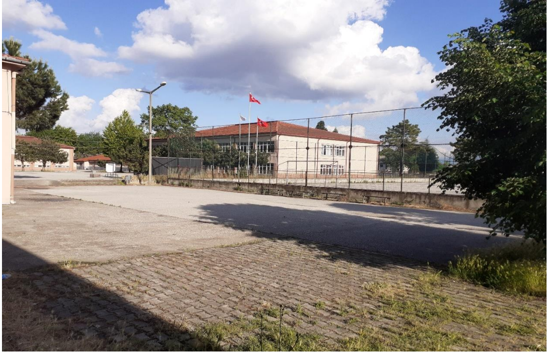
Şekil 3.30. Tekeler mahallesi 89 numaralı toplanma alanı.
