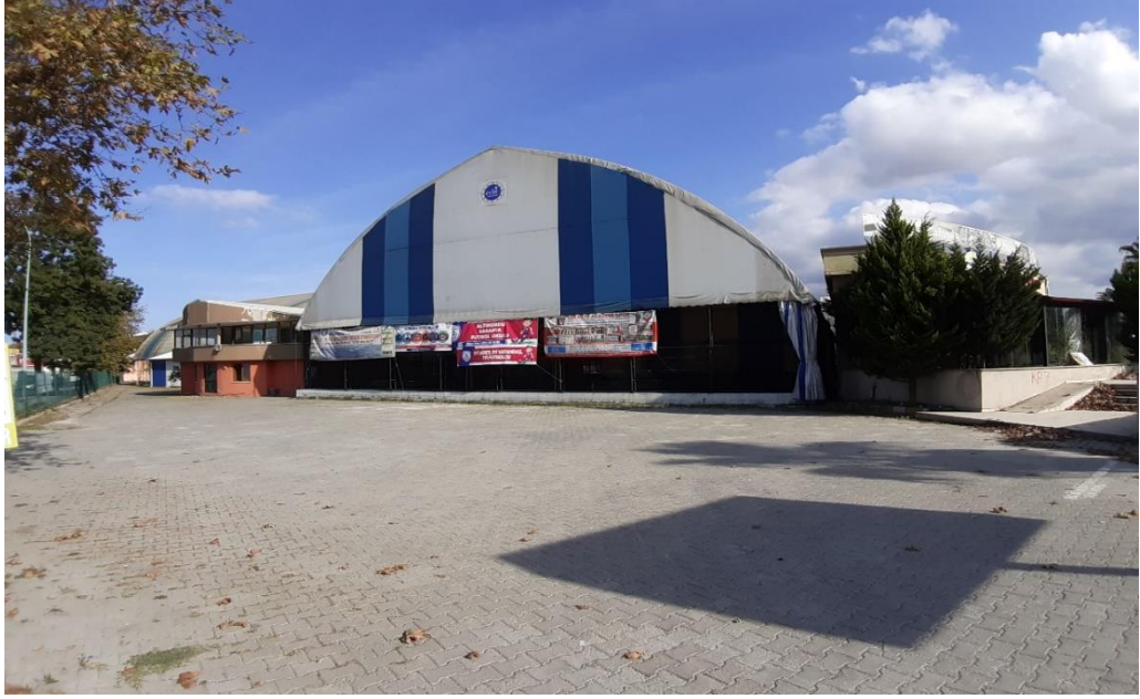
Şekil 3.205. Mithatpaşa mahallesi 22 numaralı acil durum toplanma alanı.
