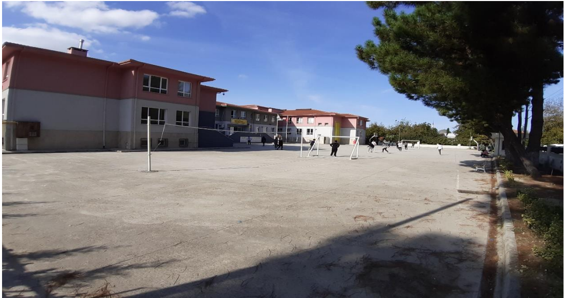
Şekil 3.213. Mithatpaşa mahallesi 27 numaralı acil durum toplanma alanı.
