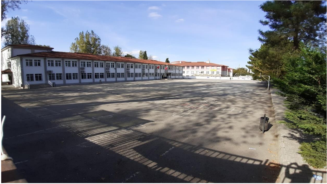
Şekil 3.211. Mithatpaşa mahallesi 26 numaralı acil durum toplanma alanı.
