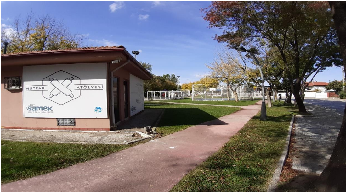
Şekil 3.225. Mithatpaşa mahallesi 33 numaralı acil durum toplanma alanı.
