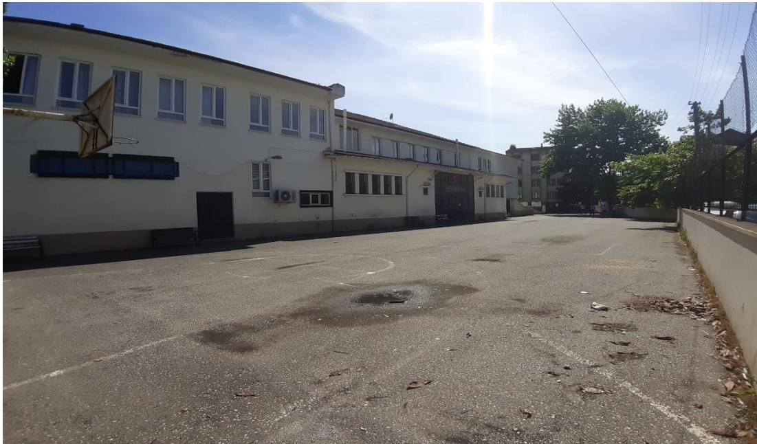
Şekil 3.97. Karaosman mahallesi 80 numaralı acil durum toplanma alanı.
