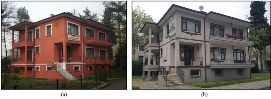
Şekil 5.42. (a) Orijinal TZDK lojman binasının İl Özel İdaresi Kütüphanesi olarak geçici kullanımı (Url 27), (b) Orijinal TZDK lojman binasının Sait Faik Kütüphanesi olarak güncel çağdaş kullanımı, 2020
