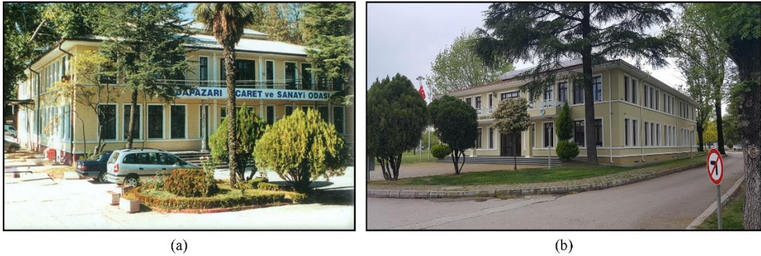
Şekil 5.32. (a) Müdüriyet binasının ATSO tarafından geçici kullanımı (Resul Narin arşivi), (b) Müdüriyet binasının İmar ve Şehircilik Daire Başkanlığı tarafından güncel kullanımı
