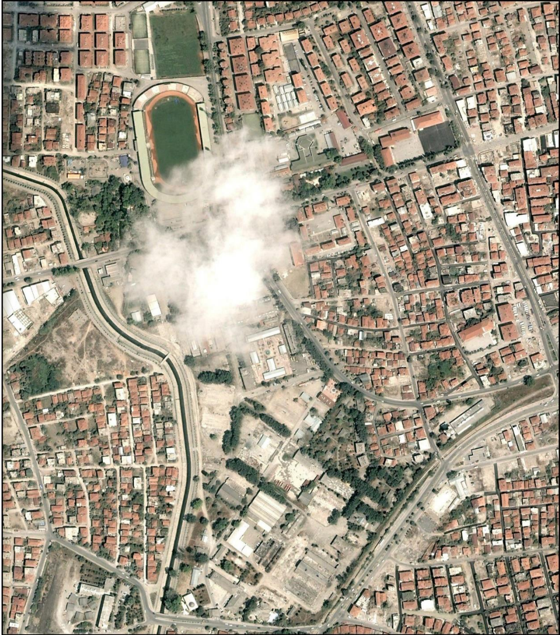
Şekil 5.15. 2003 tarihli hava fotoğrafında terk edilme ve deprem sonrası atıl kalan fabrika yapıları
