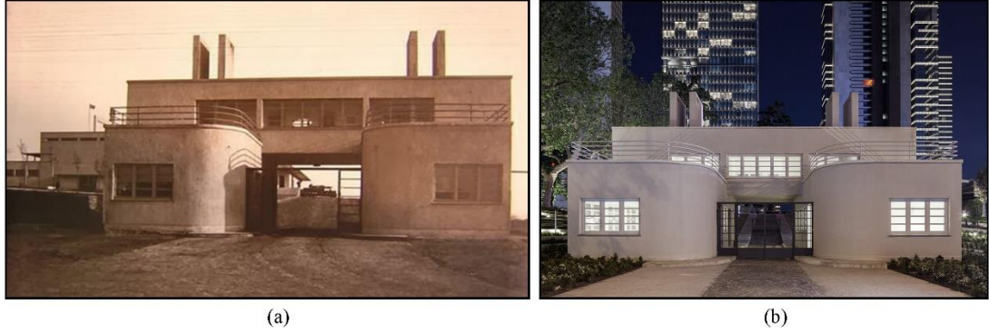
Şekil 3.13. (a) Ali Sami Yen'in inşası sırasında yıkılan orijinal giriş pavyonu (URL-17, 2020), (b) yeniden ihya edilen giriş pavyonu (URL 18, 2020)
