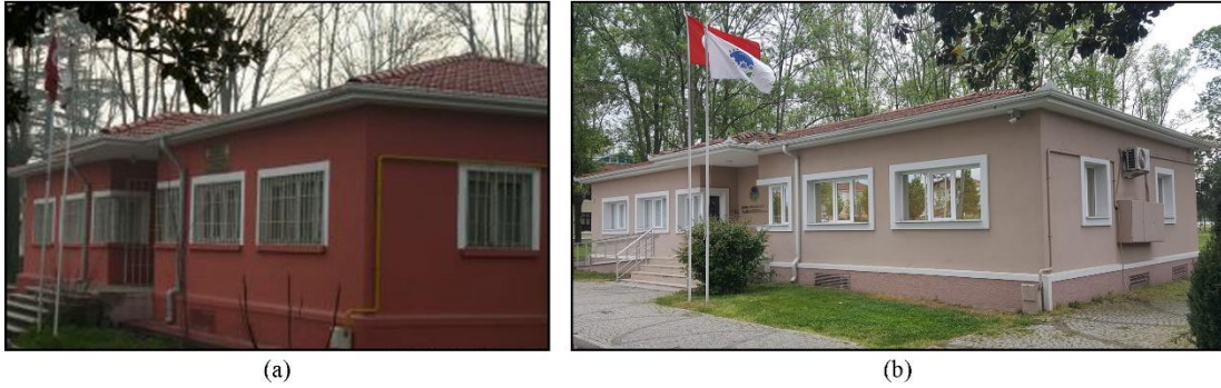
Şekil 5.40. (a) Orijinal TZDK lojman binasının Çocuk ve Gençlik Merkezi olarak geçici kullanımı (Url 27), (b) Orijinal TZDK lojman binasının YADEM olarak güncel çağdaş kullanımı, 2020
