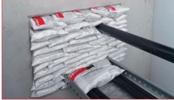
Şekil 4.23. Yangın durdurucu yastıklar [43]
