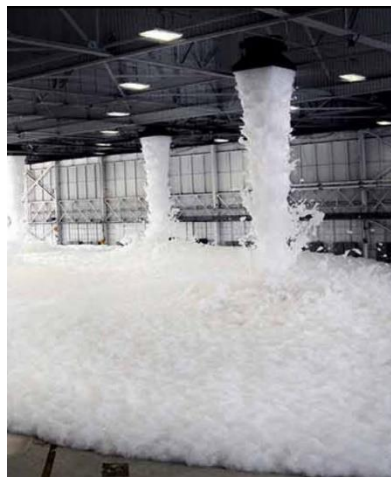
Şekil 4.58. Otomatik köpüklü yangın söndürme sistemi [62]
