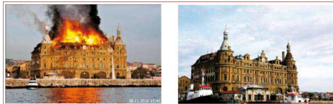
Şekil 3.11. Haydarpaşa Garı çatı yangını [17]
