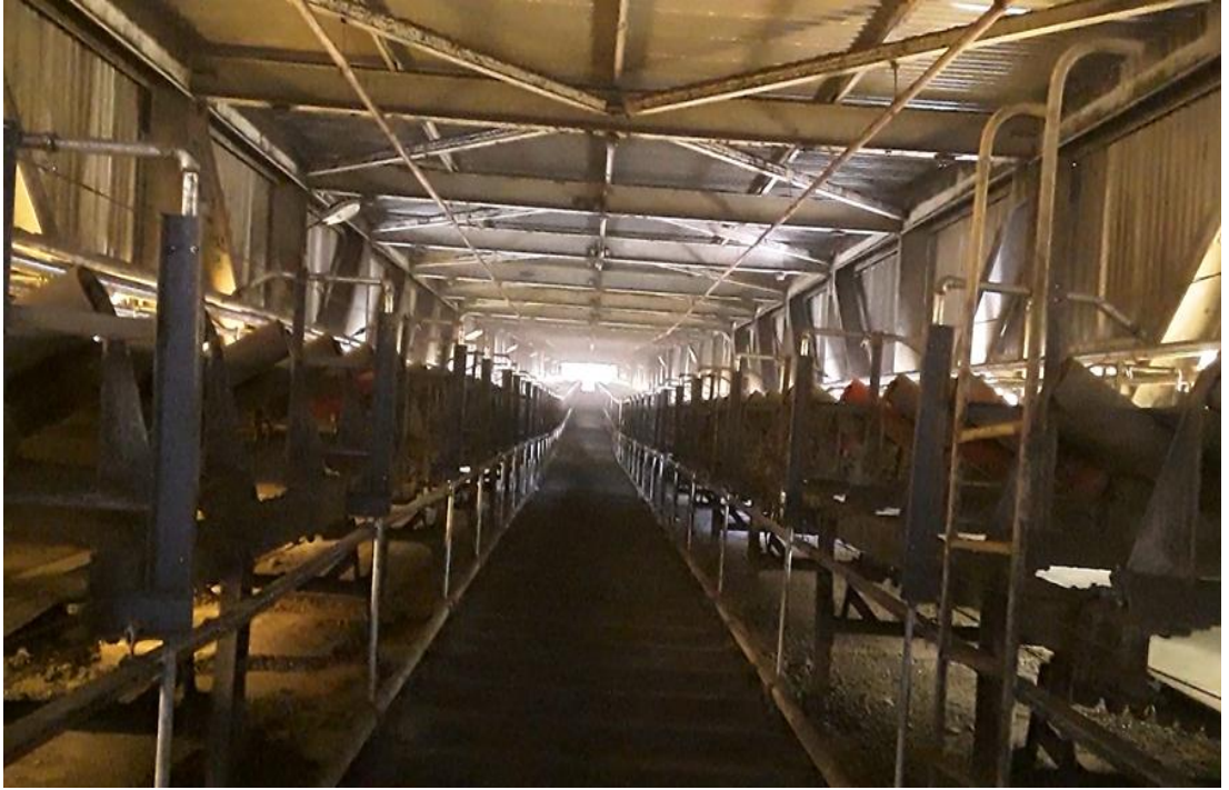
Şekil 3.2. Yeniköy rampa konveyörü
