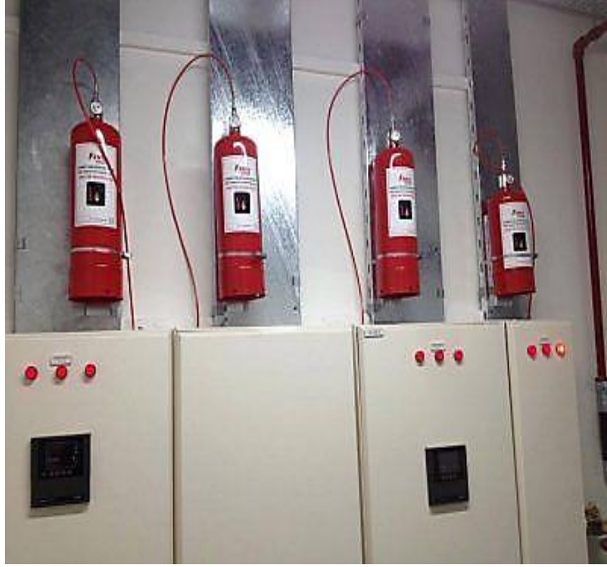
Şekil 4.7. Gazlı yangın söndürme sistemleri örnek uygulama
