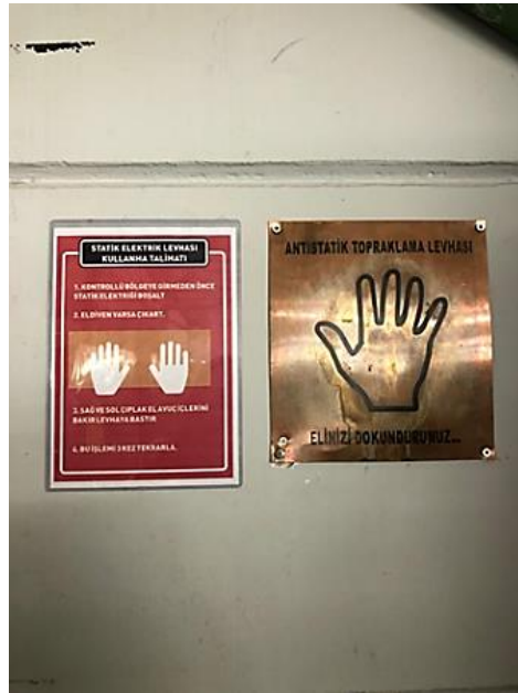
Şekil 4.1. Üretim alanında bulunan statik elektrik levhası
