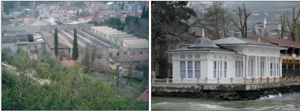
Şekil 6.3. Çuha, fes dairesi ve boyahane olarak kullanılan yapı (Solda), Köşk yapısı (Sağda)
