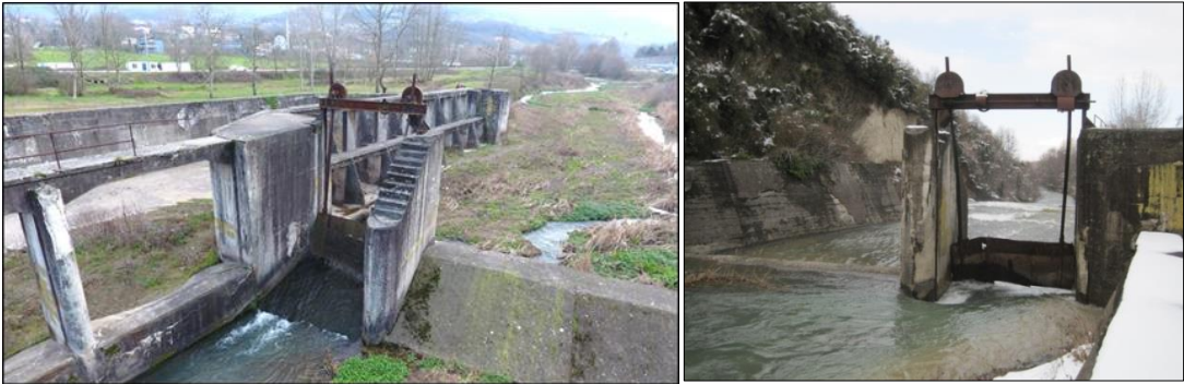
Şekil 5.35. Hidroelektrik santrali baraj kısmı (Kartepi Belediyesi Arşivi, 2018 )
