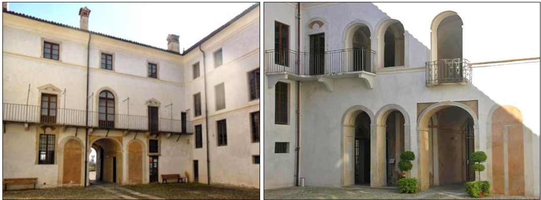
Şekil 6.46. Fabrikanın günümüzdeki dış cephe görüntüleri
