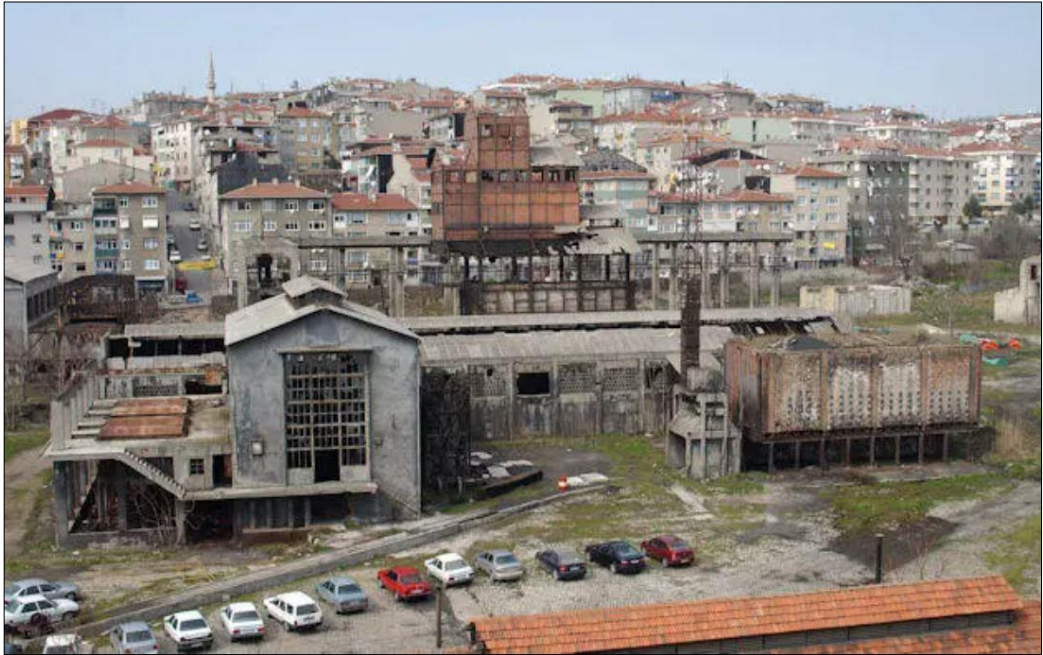
Şekil 6.7. Fabrika alanı yapılarının işlevlendirme öncesi durumu (URL-39)
