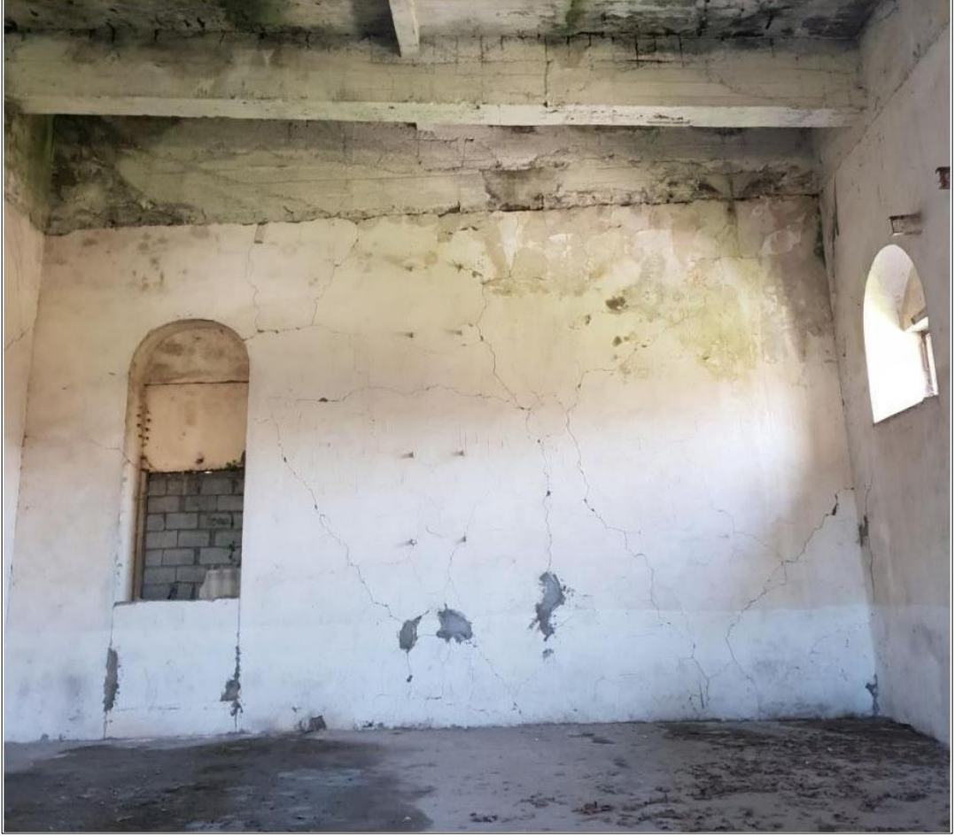
Şekil 5.130. Z02-Ambar-2 kodlu alanın kapatılmış pencere boşluğu
