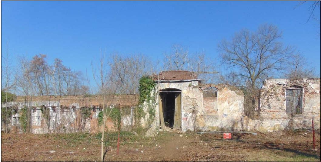
Şekil 5.20. Dokuma Atölyesi Binası (Kartepe Belediyesi Arşivi, 2018)
