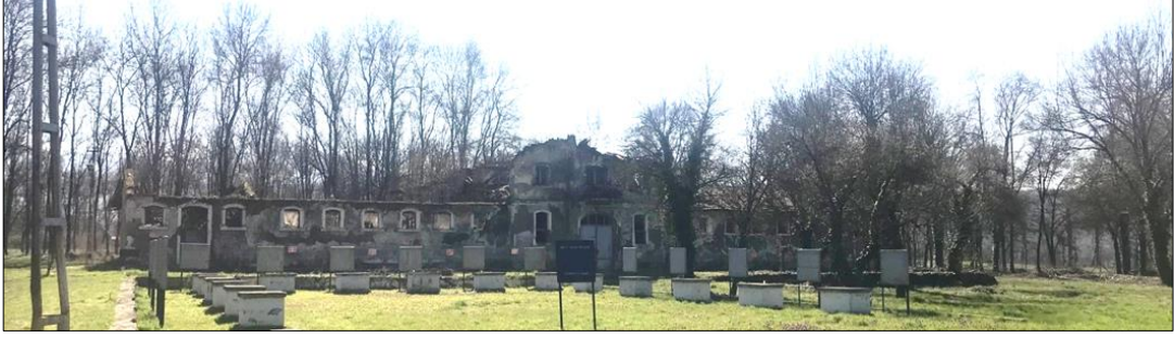
Şekil 5.66. Av Köşkü Mevcut Durum Kuzey Cephe Fotoğrafı (Yazarın fotoğraf arşivi Tarih: 05.03.2019)
