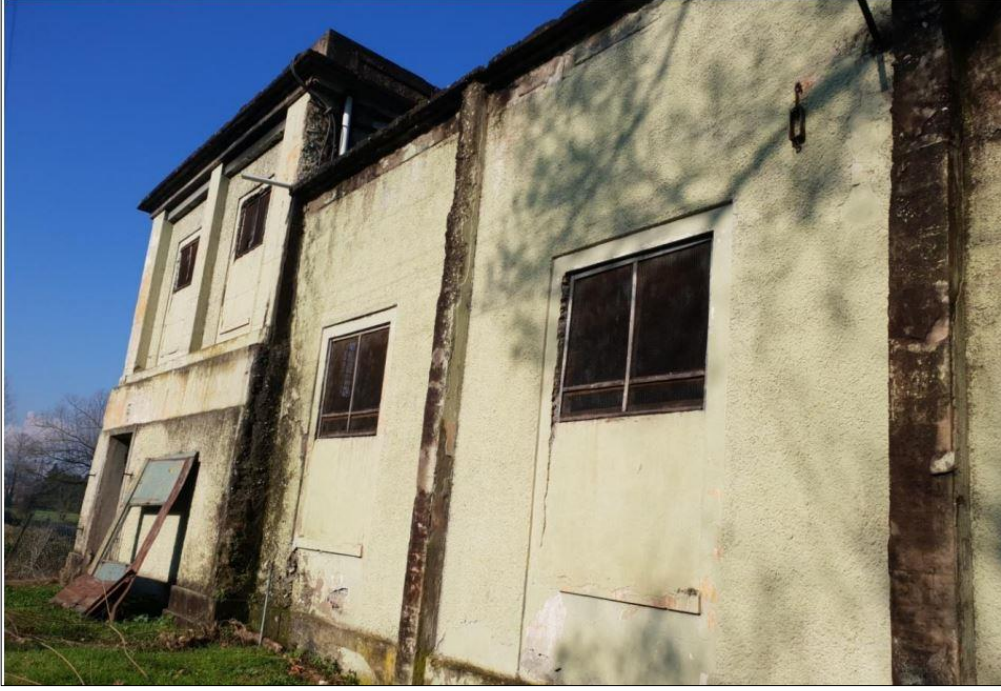
Şekil 5.164. Hidroelektrik santrali Güney Doğu Cephesi (Yazarın fotoğraf arşivi)
