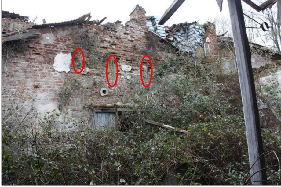
Şekil 5.76. Z01 ve Z04 numaralı mekanlar arasındaki duvarda yer alan demir kılıçlar (Kartepe Bel. Arşivi)
