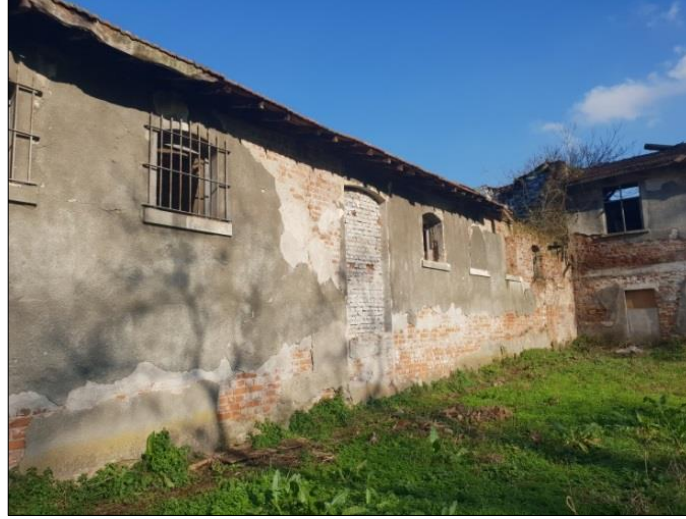
Şekil 5.95. Dış cephenin toprak zemin ile bağlantısı
