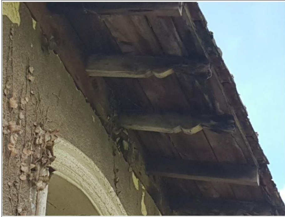
Şekil 5.84. Yapının ahır mekanlarının çatı örtüsünde yer alan günümüze ulaşmış olan özgün profilli mertekler
