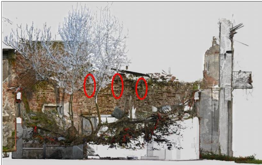
Şekil 5.77. Z01 ve Z02 nolu mekanlar arasındaki duvarda yer alan demir kılıçlar (Kartepe Belediyesi Arşivi)
