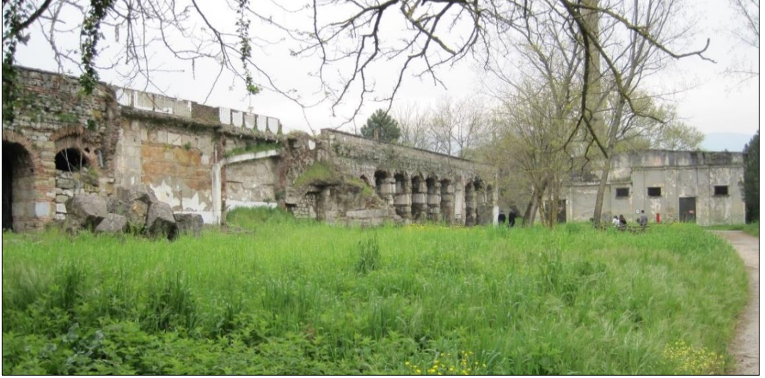
Şekil 5.27. Bedesten (Fabrika Yapısı) ve Bacalı Ambar Yapısı (Kartepe Belediyesi Arşivi)
