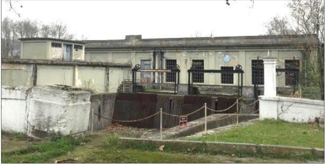
Şekil 5.152. Hidroelektrik Santral Binasının günümüzdeki durumu (Kartepe Belediyesi Arşivi, 2018)
