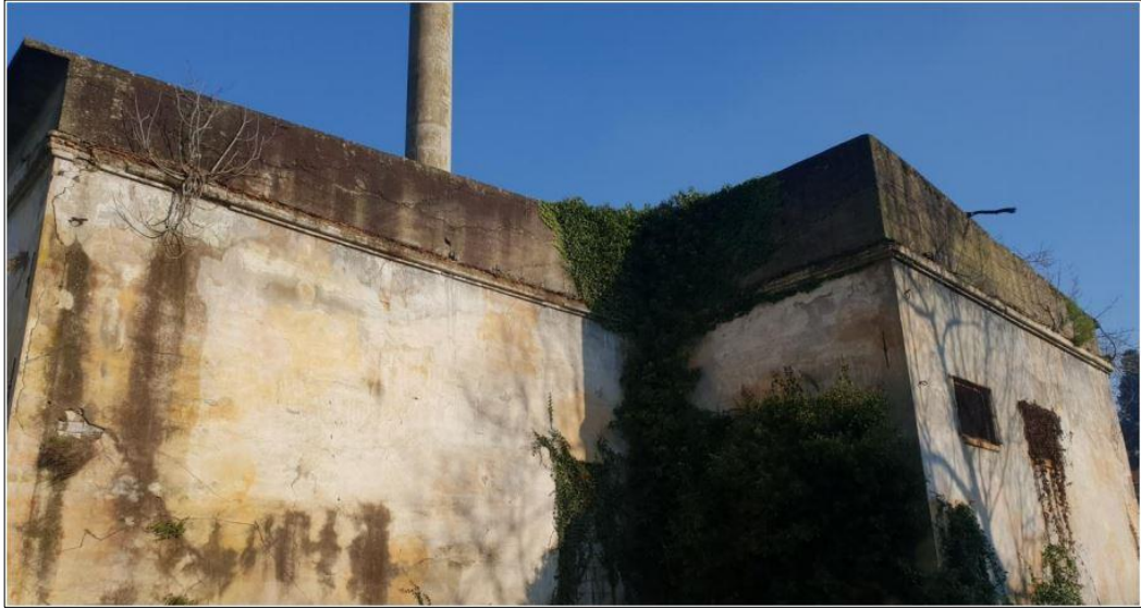
Şekil 5.149. Bacalı Ambar güney cephesi
