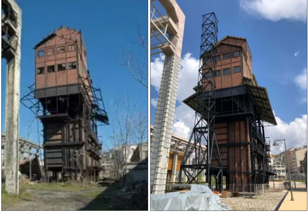
Şekil 6.6. Yapının atıl durumdaki hali (solda), Yeniden işlevlendirilmiş hali (sağda)(URL-38)
