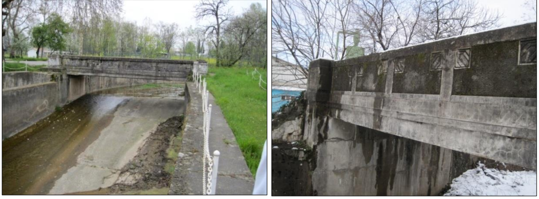
Şekil 5.36. Hidroelektrik santrali köprü kısmı (Yazarın Fotoğraf Arşivi)
