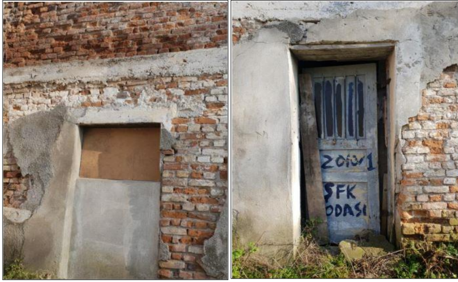
Şekil 5.92. Batı cephesinde örülerek daraltılmış pencere ve kapı boşlukları
