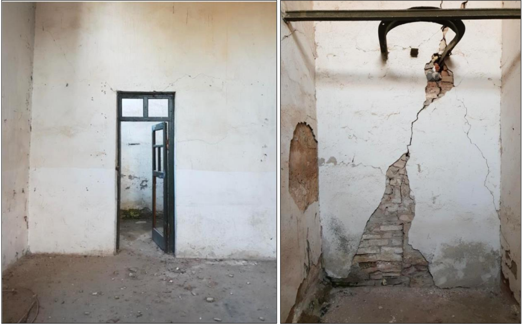
Şekil 5.124. Z02 nolu hacim (AMBAR-2) Muhdes Ahşap Kapı (Solda), Z03 Nolu Hacim (Oda)(Sağda)
