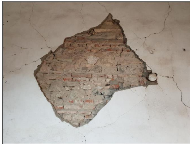
Şekil 5.126. Z01-Ambar-1 kodlu odadan kagir duvar dokusu
