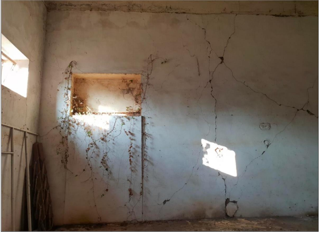
Şekil 5.116. Z01 nolu hacim (AMBAR-1), (Kapatılmış Pencere Boşluğu)
