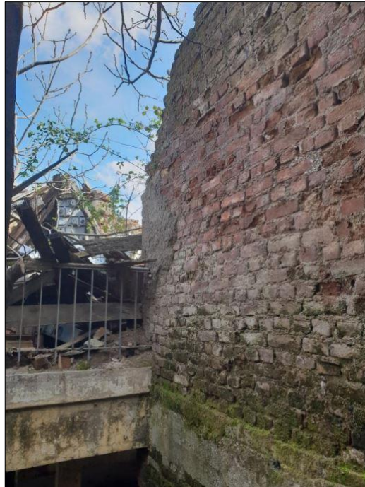
Şekil 5.88. Merdiven sahanlığının yan duvarındaki ve Z01 numaralı mekânda bulunan betonarme kirişler
