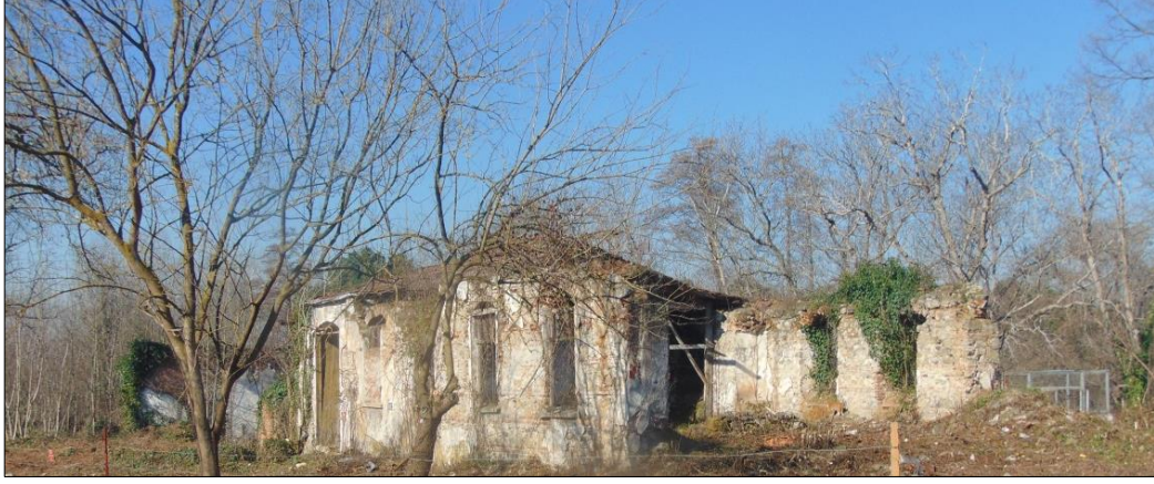
Şekil 5.21. Dokuma Atölyesi Binası (Kartepe Belediyesi Arşivi, 2018)
