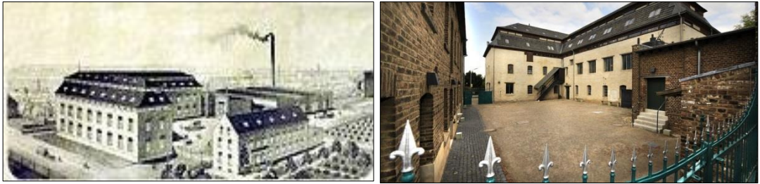
Şekil 6.40. 1810 yılı fabrika yapısının görünümü (Solda) , Ana binası ve iç avlusu (Sağda)
