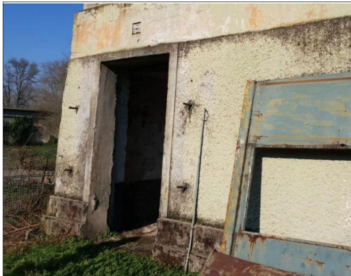
Şekil 5.157. Bahçeye açılan kapı boşluğu (Karteppe Belediyesi Arşivi, Rölöve Raporu)
