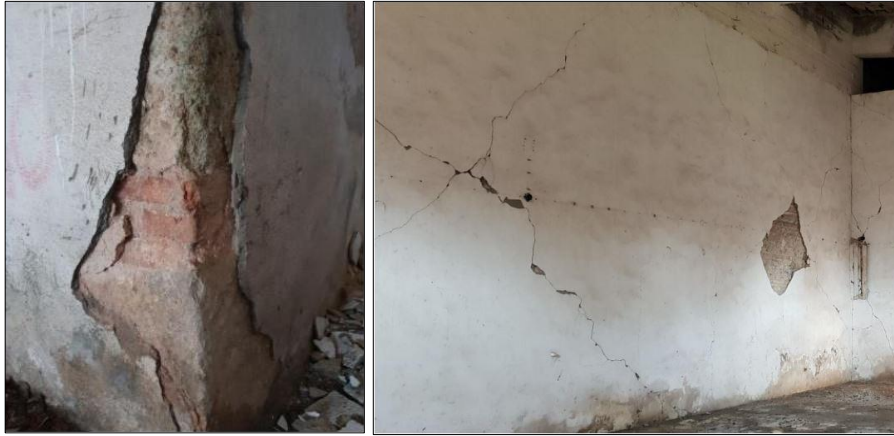
Şekil 5.144. Bacalı Ambar'ın baca kısmındaki sıva katmanları (solda), sıva bozulmaları örneği (sağda)
