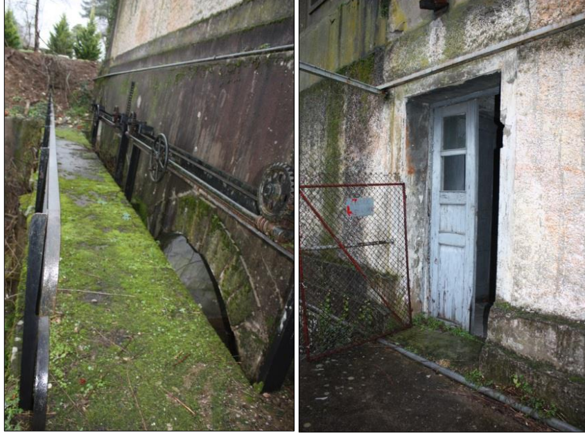
Şekil 5.173. Batı cephesi betonarme balkon kısmı (soyda) ve kapı kısmı (sağda)
