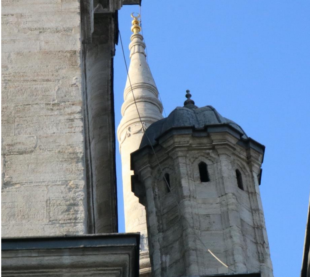
Şekil 5.14. Nuruosmaniye Camii minare külah kısmı örneği
