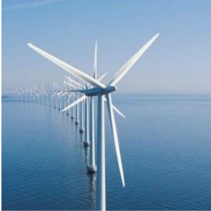
Şekil 3.5. Yatay eksenli rüzgâr türbinleri [10]
