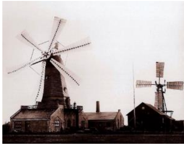
Şekil 3.2. Poul La Cour un tasarladığı rüzgâr türbini [6]
