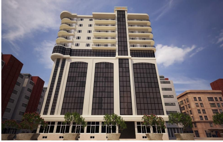
Şekil A.1. Binanın ön görünümü
