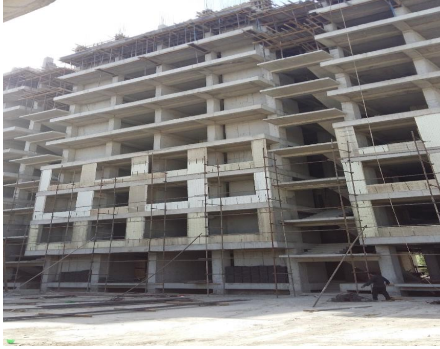
Şekil B.7. Binaın arka görünümü
