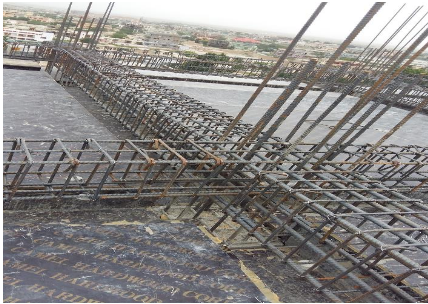
Şekil B.6. Binanın döküzcüncü kat kiriş kesiti
