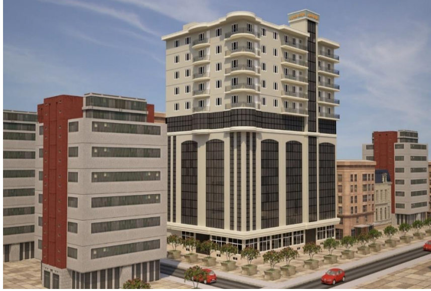
Şekil A.3. Binanın yan görünümü
