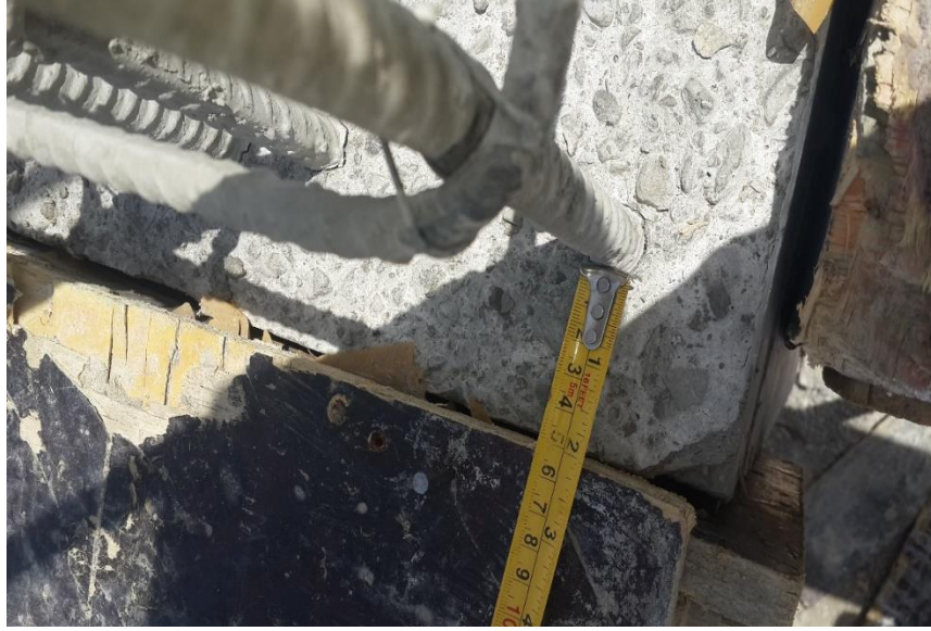
Şekil B.3. Binanın döküncü kat kolon kesiti
