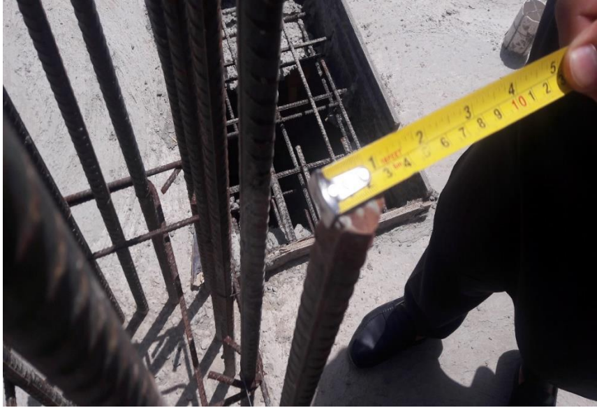
Şekil B.1. Binanın ikinci kat kolon donatısı
