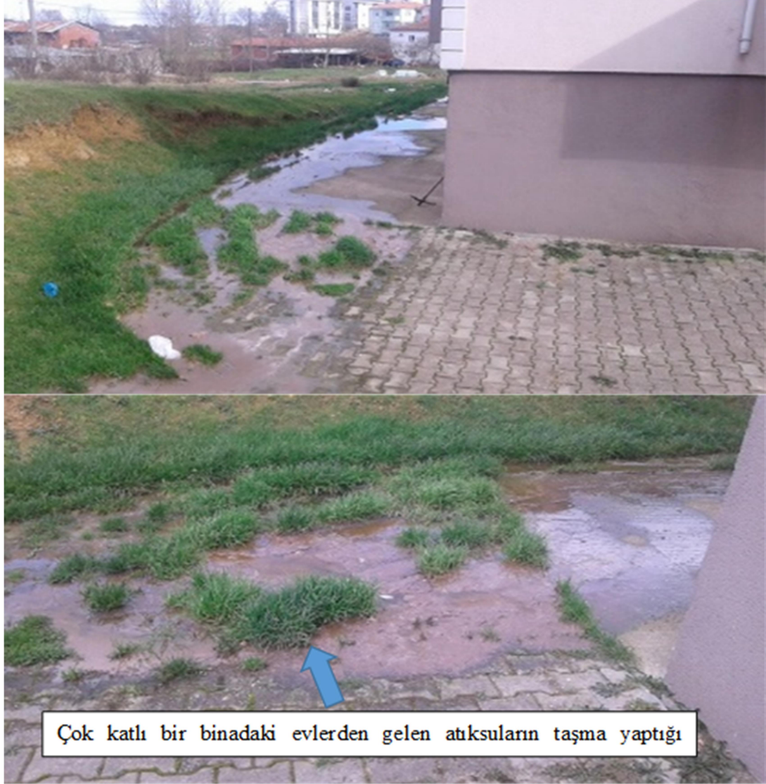
Őekil 4.6. Binaların pıssu giderlerine yeteri kadar eęim verilmemesi durumunda meydana gelen tıkanma problemlerine rnekler.
