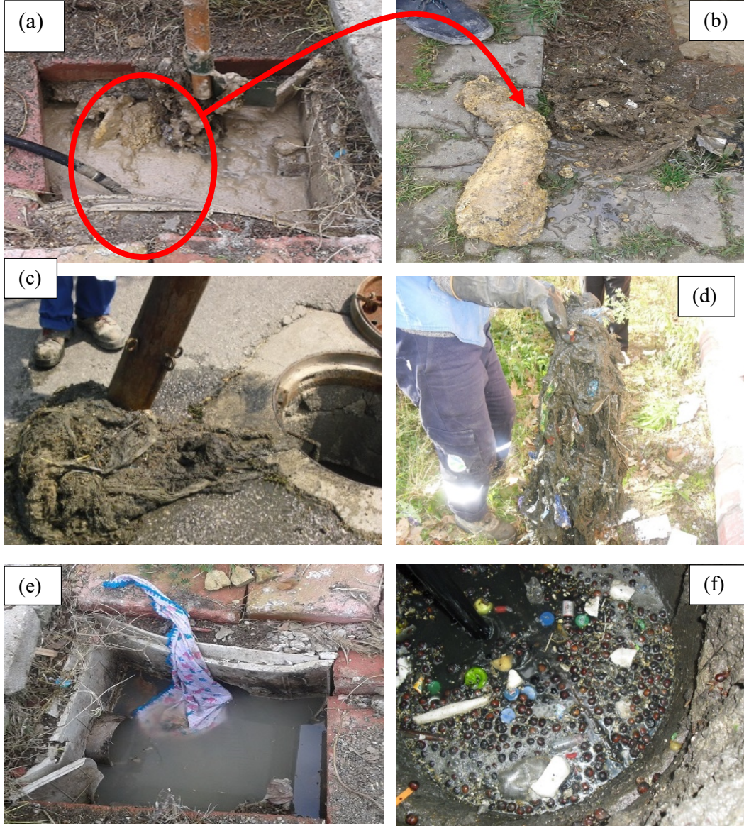
Şekil 1.1. Kanalizasyon tıkanmalarının giderilmesi sırasında belirlenen ve tıkanmalar sebep olan maddelere örnekler. (a) Kızartma yağlarının atıksudaki diğer maddelerle birleşerek oluşturduğu çok sert çökelekler, (b) Yağlarla oluşan çökeleklerin yakından çekilmiş fotoğrafı, (c) Sıradan bir kanal açma çalışması sırasında ortaya çıkan karışık atıklar: Tuvalet kağıdı, ıslak mendil vb. atıkların birleşmesiyle oluşmuş bir yığın, (d) Bir kanal açma çalışması sırasında ortaya çıkarılan atıklar: Tuvalet kağıdı, ıslak mendil, ambalaj atıkları, ve sokak süprüntülerinin birleşmesiyle oluşmuş bir yığın, (e) Bebek battanisi, (f) Kabuklu kuruyemiş (fındık), meyve, sebze, ve plastik parçalar gibi atıkların birleşmesiyle meydana gelmiş bir tıkanma olayı.
