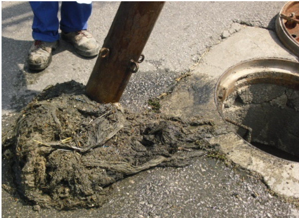
Şekil 4.1. Kanalizasyon sistemlerindeki ana kanal ve baca tıkanıklıklarına örnek
