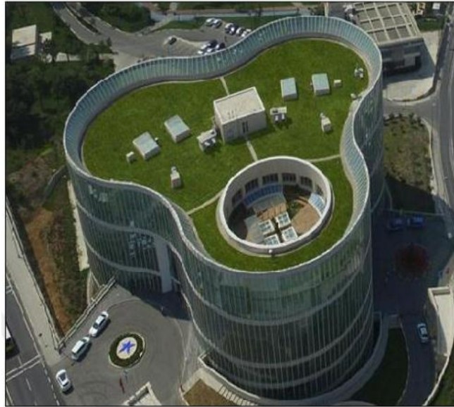
Şekil 5.46. Küçükçekmece Belediye Binası
