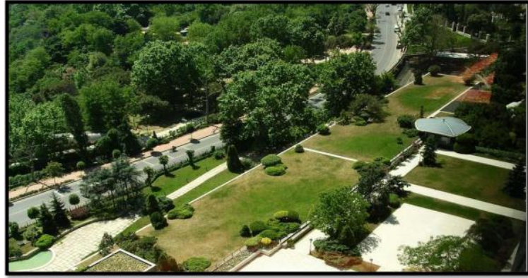
Şekil 5.73. Hilton Oteli yeşil çatısının üstten görünümü [7]
