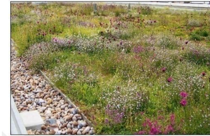
Şekil 1.4. Ekstensif yeşil çatı
