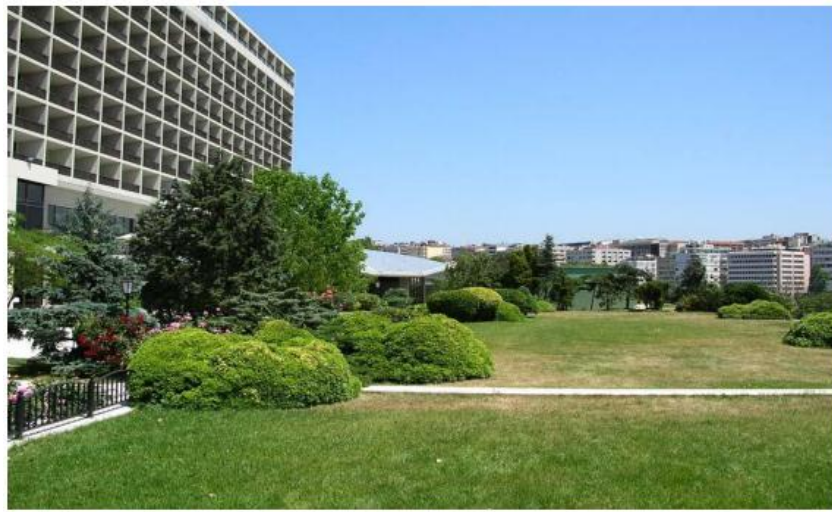
Şekil 5.74. Hilton Oteli ek binası üzerindeki yeşil çatı [7]
