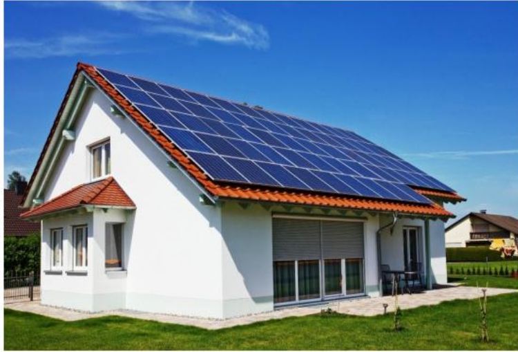
Şekil 4.1. Çatı üzeri güneş paneli kurulumu
