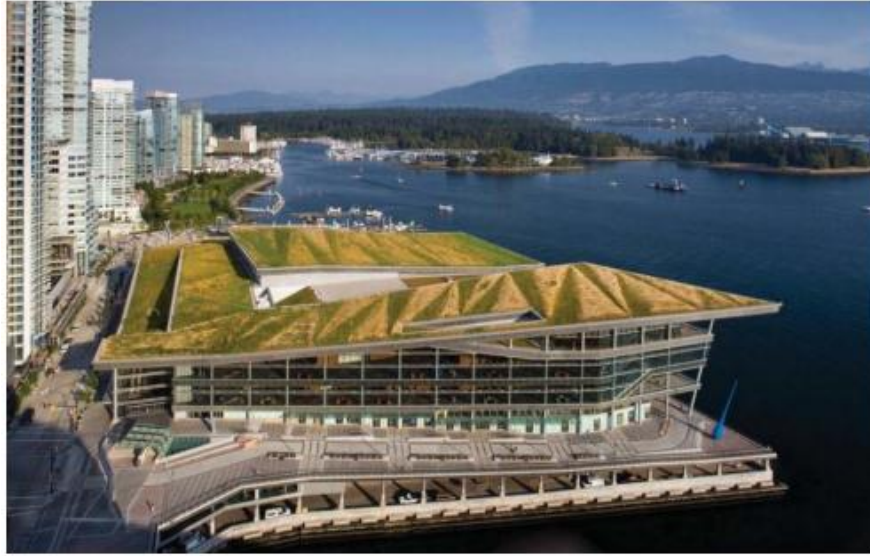
Şekil 5.34. Vancouver Kongre ve Sergi Binası
