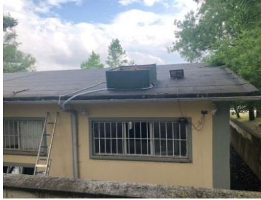
Şekil 6.10. Yeşil çatı, yağmur suyu ve güneş enerjisi sistemi
