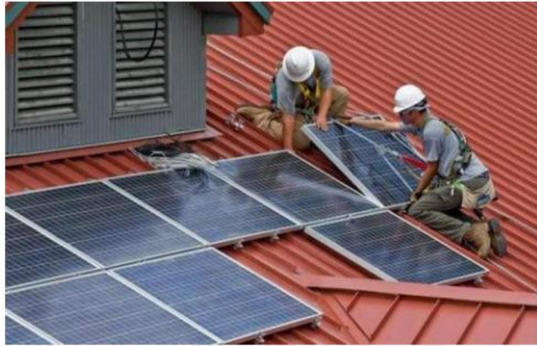
Şekil 4.4. Çatı üzeri güneş paneli kurulumu
