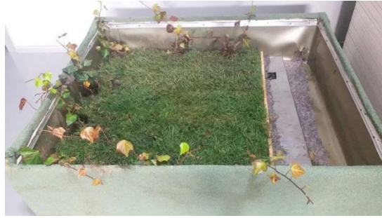
Şekil 6.8. Ekstensif yeşil çatı
