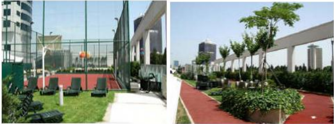
Şekil 5.71. Metrocity Alışveriş Merkezi
