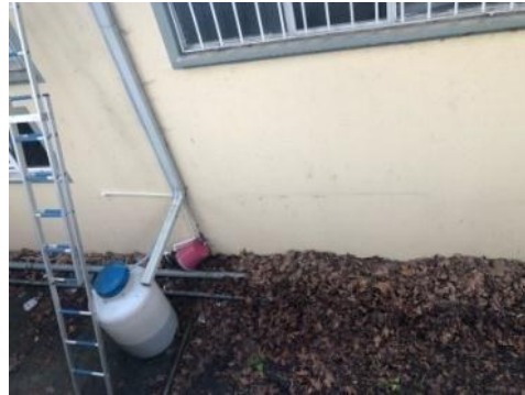
Şekil 6.9. Su deposu ve borular
