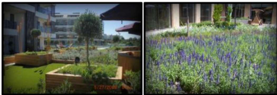
Şekil 5.77. Sensimar Hotel lokanta üzeri yeşil çatı [7]
