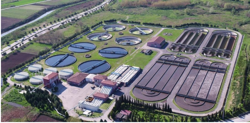
Şekil 5.9. Karaman Atıksu Arıtma Tesisi
