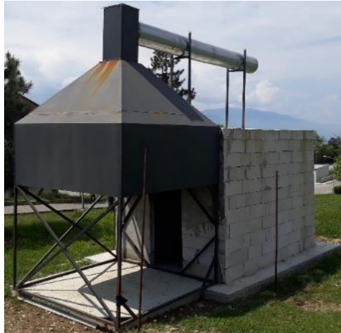
Şekil 3.2. Yangın odasının davlumbaz montaj aşamaları ve davlumbaz montajlı son hali
