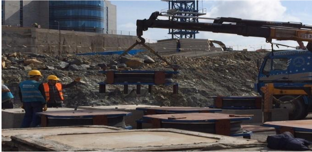
Şekil 4.2. Hastane Projesi sismik izolatör yerleştirilme anı
