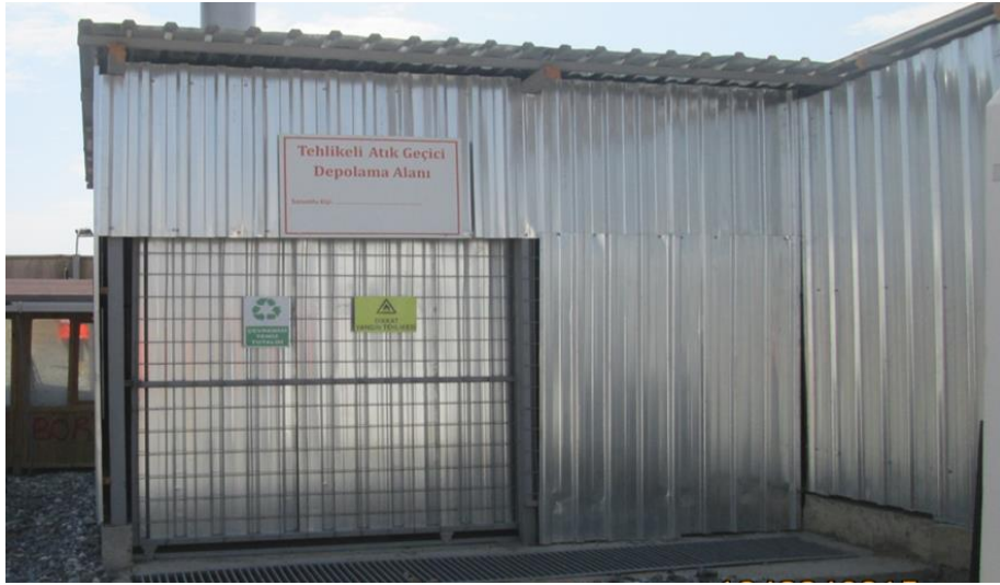
Şekil 4.3. Tehlikeli atık geçici depolama alanı
