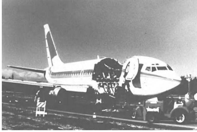
Şekil 1.2. Aloha Airlines Boeing 737, 28 Nisan 1988'deki kazası, Honolulu uluslararası havalimanı, Hawaii [4]
