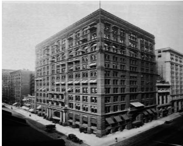
Şekil 1.2. Home Insurance Yapısı, Chicago (Yapım yılı:1885)
