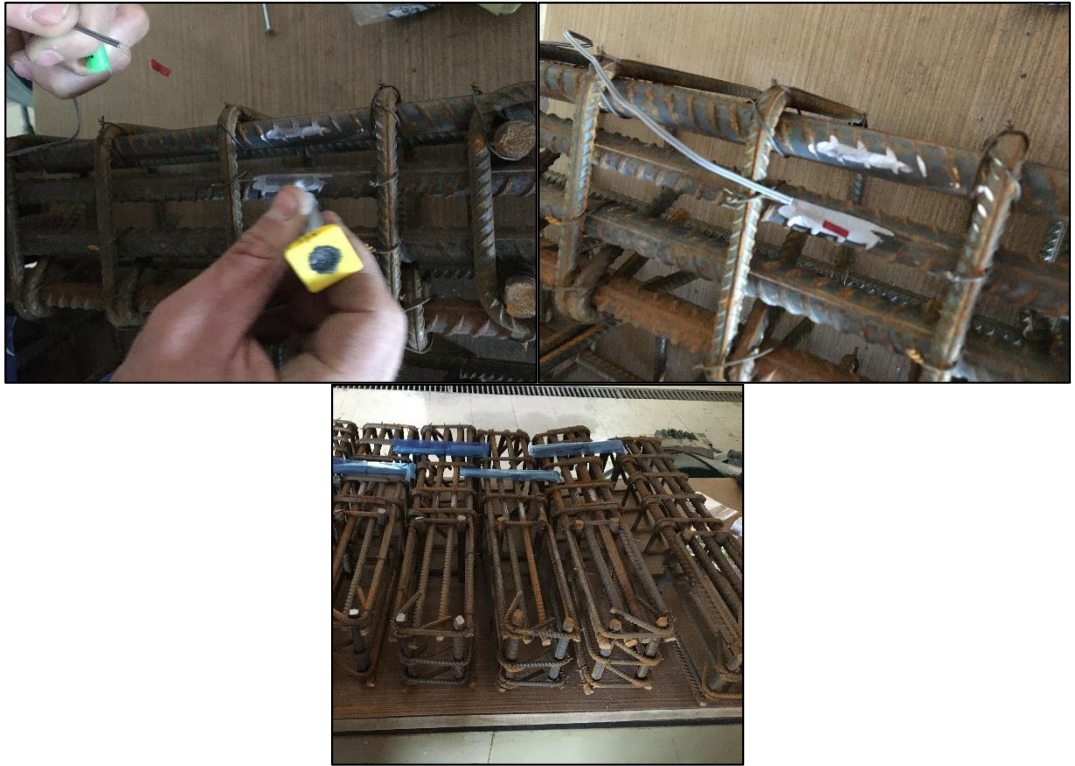
Şekil 4.13. Gerinim pullarının ilgili donatılara yapıştırılması
