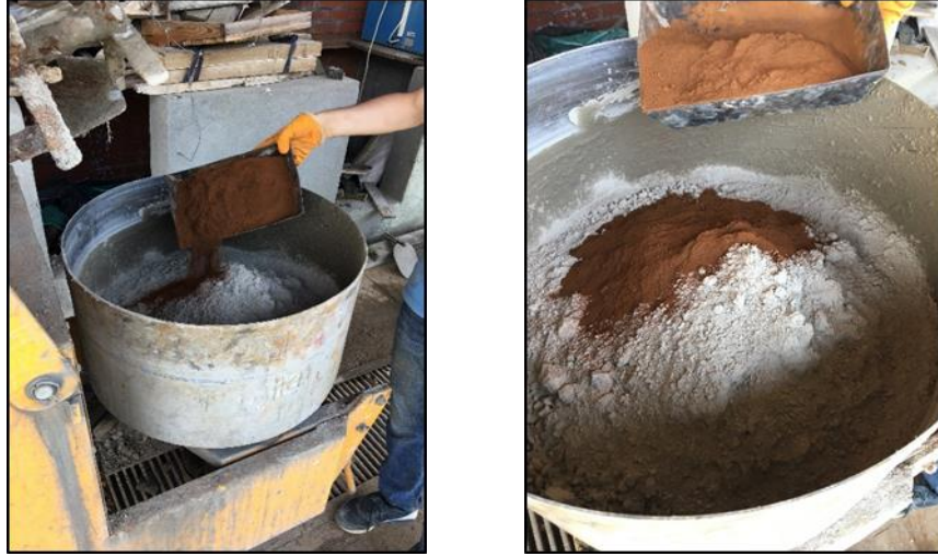
Şekil 4.15. Malzemeleri beton mikserine koyulması
