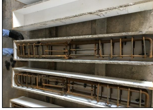
Şekil 4.17. Donatıların kalıplara yerleştirilmesi ve paspaylarının konulması
