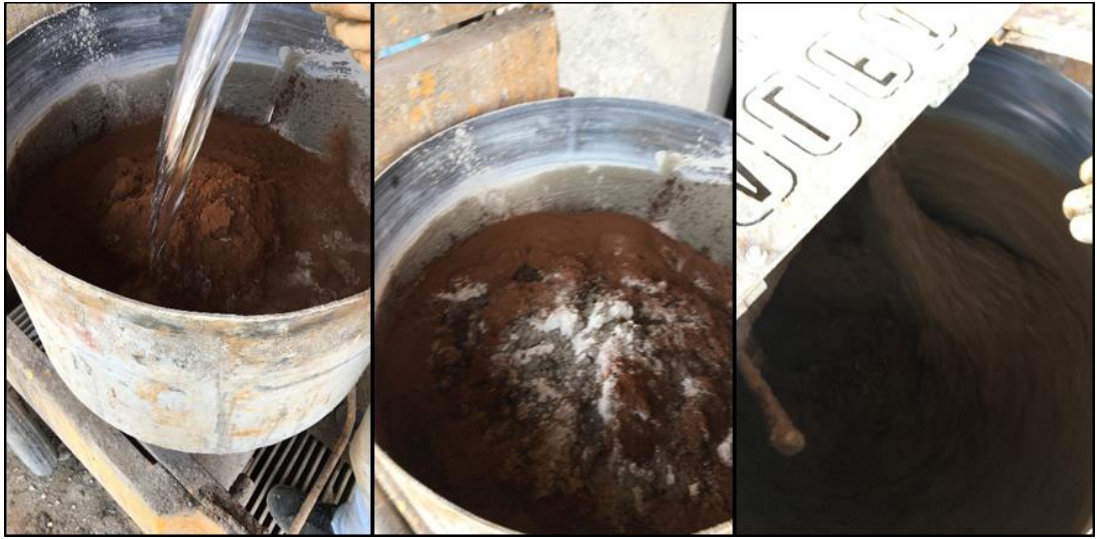
Şekil 4.16. Beton mikserindeki betonun karıştırılma esnasındaki görüntüsü
