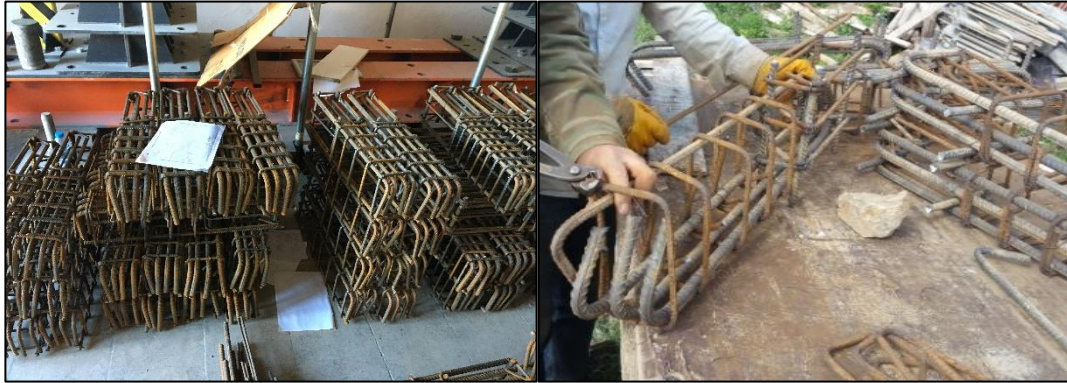
Şekil 4.8. Donatı imalatı
