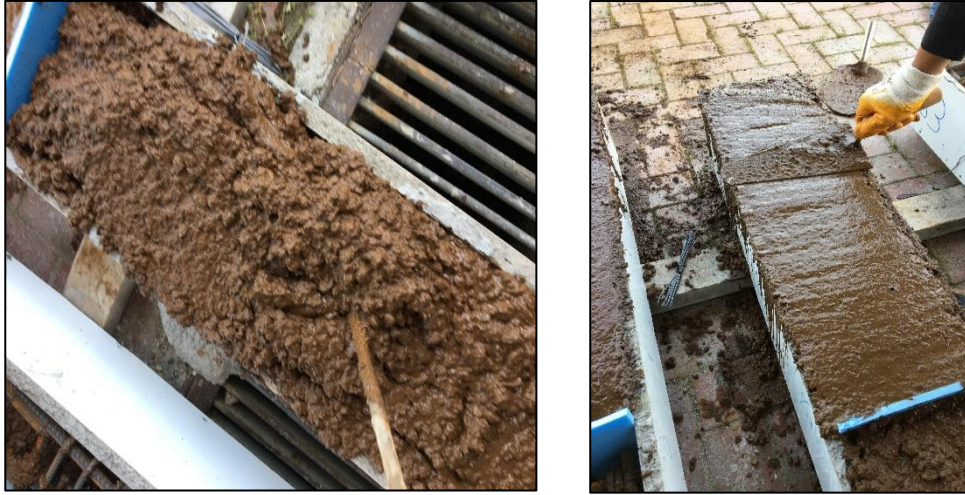
Şekil 4.18. Betonun kalıplara yerleştirilme işlemi
