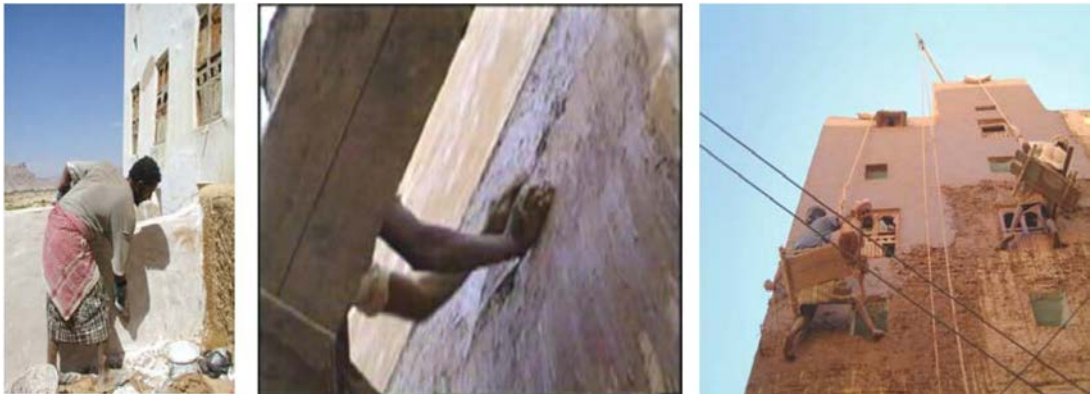
Şekil 3.8. Dış duvarların kil ve kireçle kaplanma işlemleri [27]
