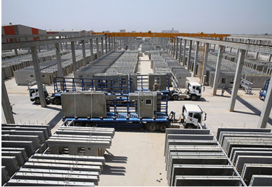
Şekil 4.35. Prefabrik yapı atölyeleri [57].
