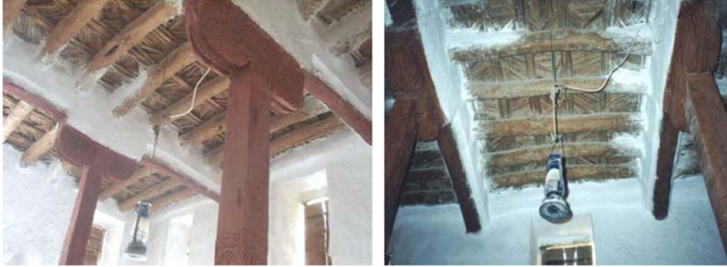
Şekil 3.7. Tavanı inşa etmek için Palmiye gövdelerinin kullanımı [27]
