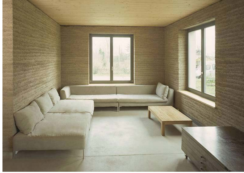
Şekil 2.18. Sıkıştırılmış toprak tekniğiyle inşa edilmiş bir konut [5].
