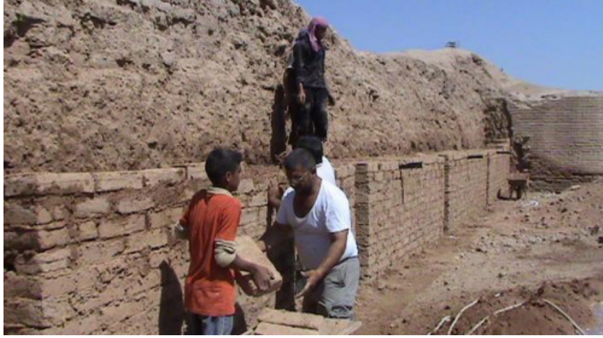
Şekil 4.28. Rakka Surları'nın güçlendirme işleri, 2009 [44].
