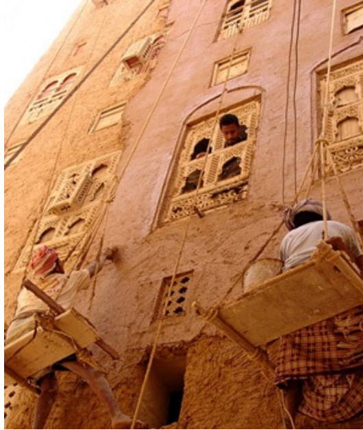
Şekil 3.6. Duvarların dış yüzlerinin kille kaplaması [29]
