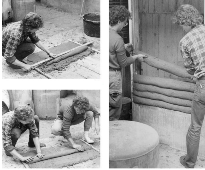
Şekil 2.15. Kil ruloların işlenmesi [18].
