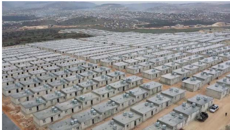
Şekil 4.36. Suriye'de İHH tarafından yapılan briket evleri [58].
