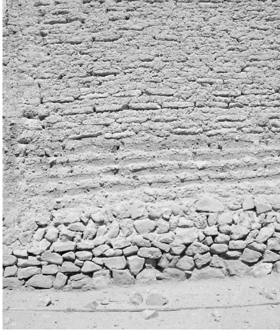
Şekil 3.15. Temel taşları ve üzeri kil duvarlar [33]
