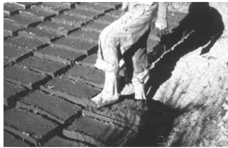
Şekil 2.4. Kil karışımını kalıplara sıkıştırma [19].
