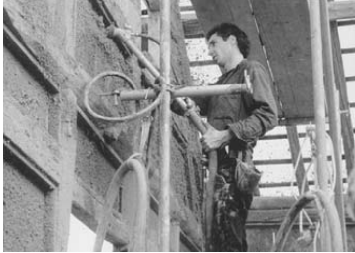
Şekil 2.17. Talaş ile kil püskürtme cihazı [19].
