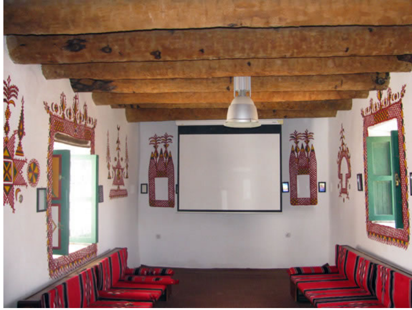
Şekil 3.14. Palmiye gövdelerinden yapılan tavan [30]
