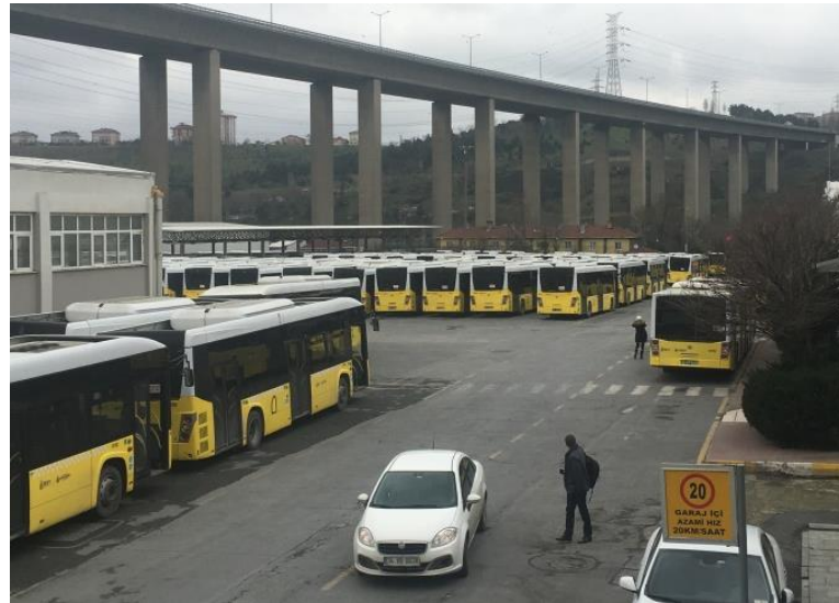
Şekil 2.16. İETT Kağıthane Garajı
