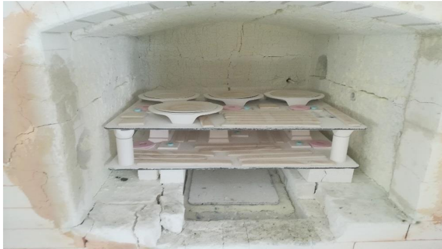
Şekil 4.9. Sinterleme fırının iç bölgesi.
