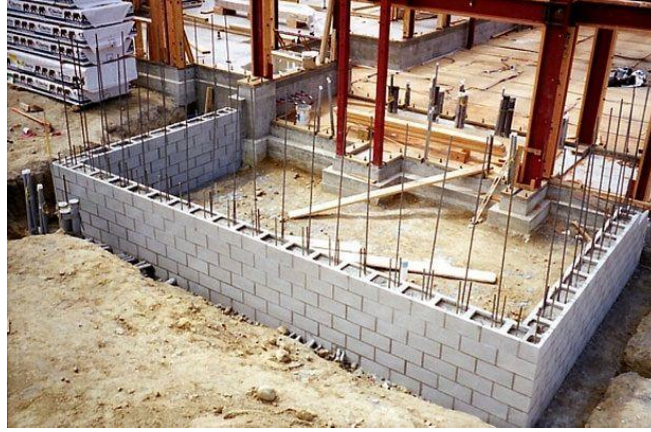
Şekil 1.1. Donatılı yığma duvar (YGM yapı güçlendirme merkezi, web sitesinden alınmıştır)
