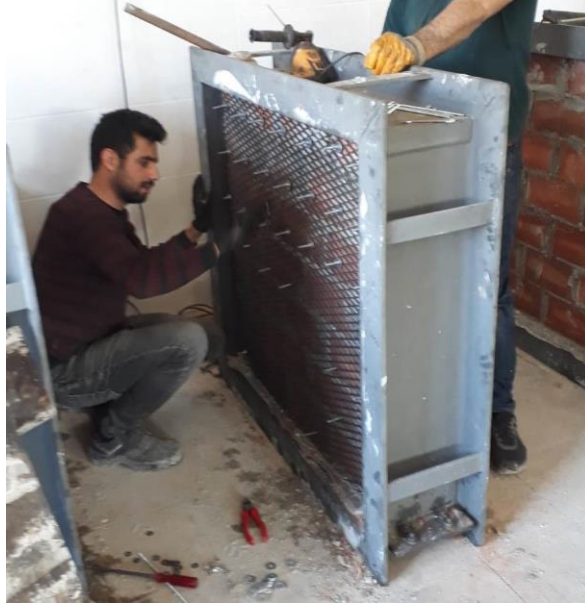
Şekil 4.21. Deney elemanlarının yapım aşamasında ankraj yapılması
