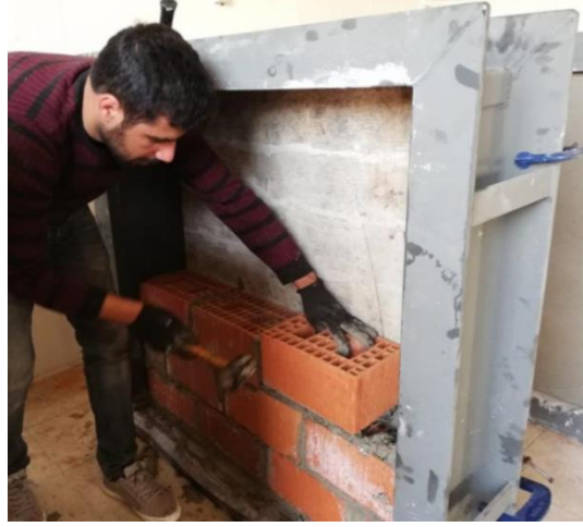
Şekil 4.18. Deney elemanlarının yapım aşamasında tuğla duvar örülmesi
