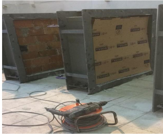
Şekil 4.20. Deney elemanlarının yapım aşamasında bulon deliklerinin açılması
