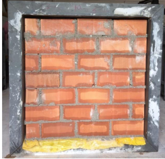
Şekil 4.19. Çerçeve içinde bitmiş tuğla duvar durumu
