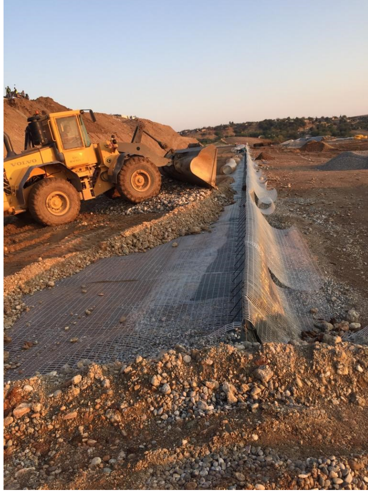
Şekil 2.1. Geogrid donatılı duvar imalatı
