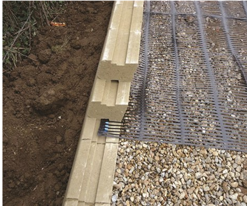
Şekil 2.2. Tek eksenli geogridle duvar imalatı (URL-2)
