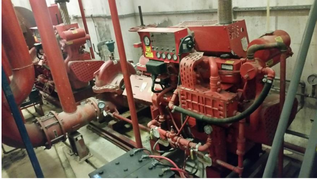
Şekil 2.31. Dizel yangın pompası görseli
