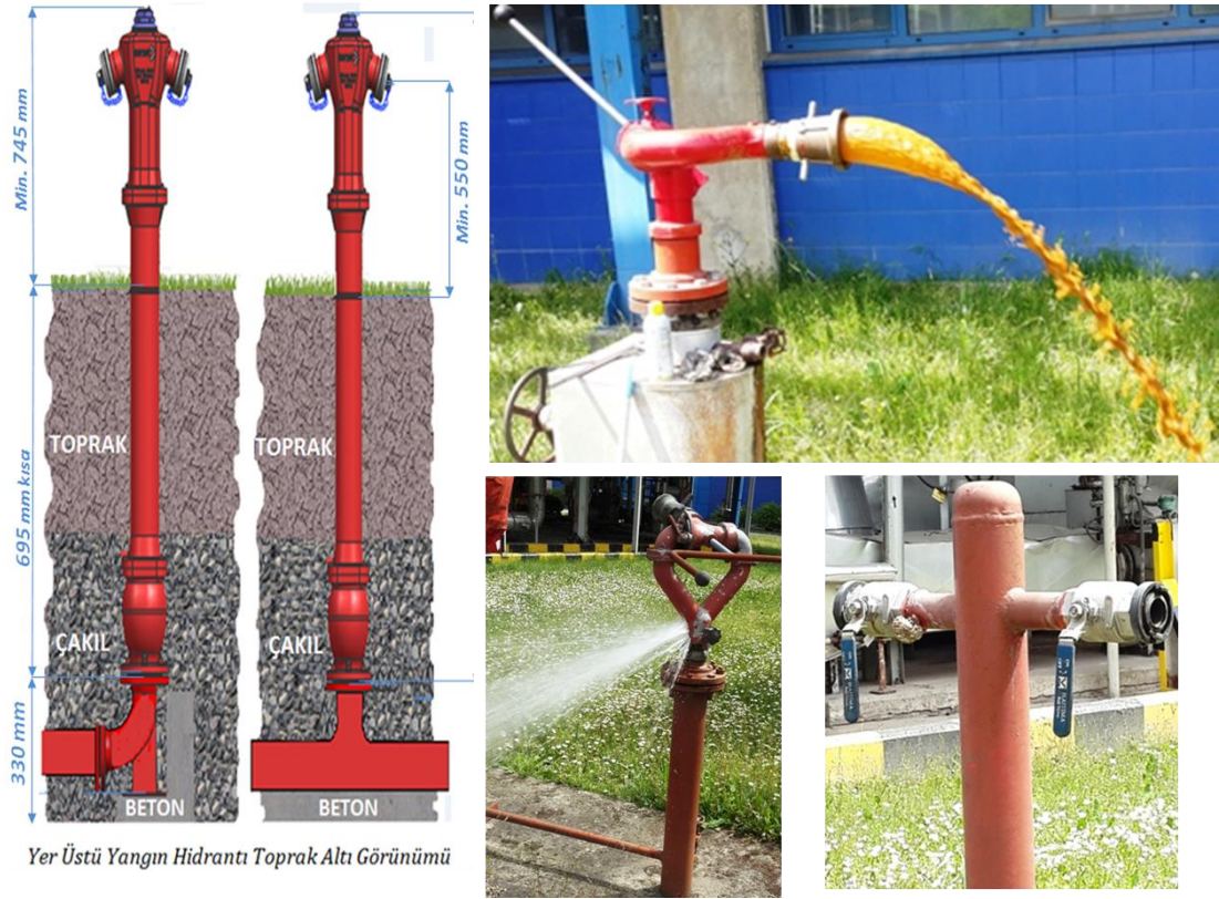
Şekil 2.47. Yangın hidrant ve monitörler
