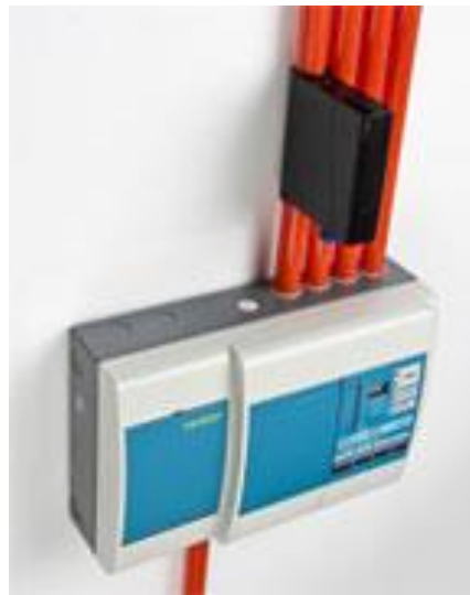
Şekil 2.21. Hava örnekleme cihazı görseli
