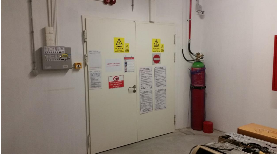
Şekil 2.23. Gazlı söndürme sistemi genel görünümü
