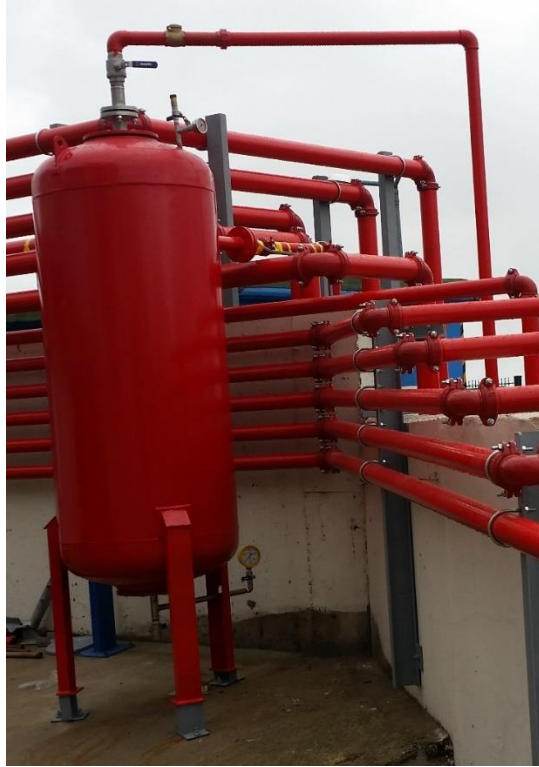
Şekil 2.12. Balder tank sistemi genel görseli
