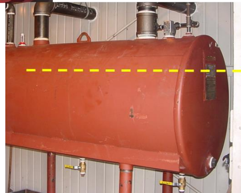
Şekil 2.49. Dziel yangın pompası yakıt deposu
