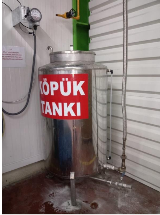
Şekil 2.13. Atmosferik köpük tankı görseli
