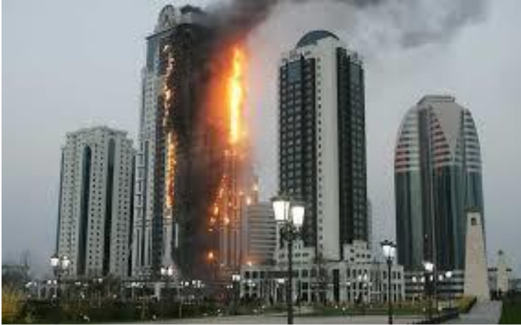
Şekil 2.52. Dış yüzeyi yanan yüksek katlı yapı
