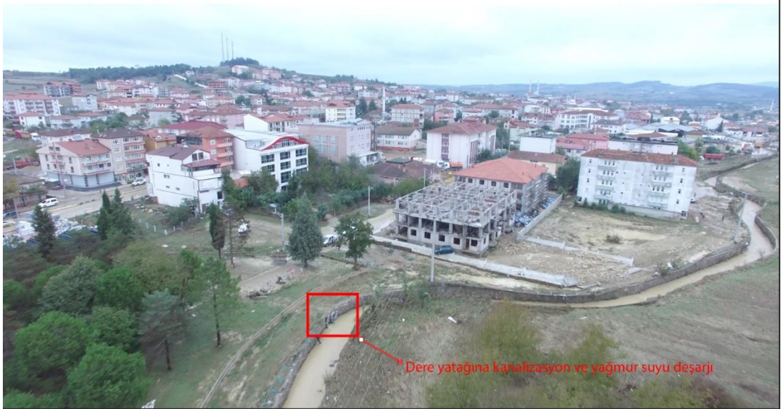
Şekil 2.5. Sakarya, Kaynarca, Seyren deresi uygunsuz kanalizasyon ve yağmur suyu deşarjı
