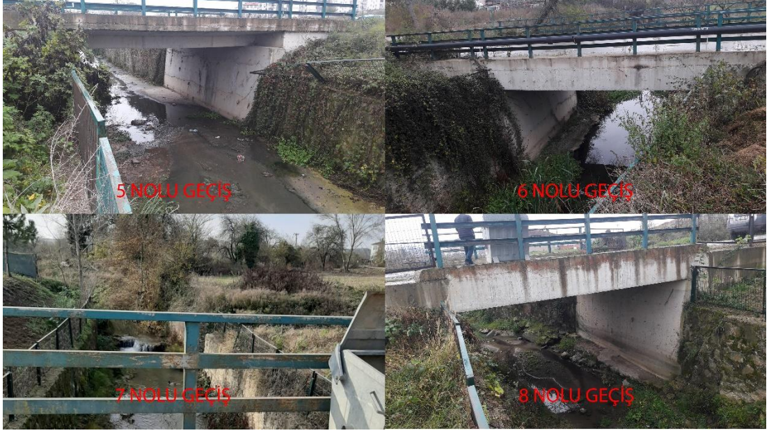
Şekil 5.9. Kaynarca ilçe merkezinde Seyren deresi üzerindeki 5,6,7 ve 8 nolu geçiş yapıları
