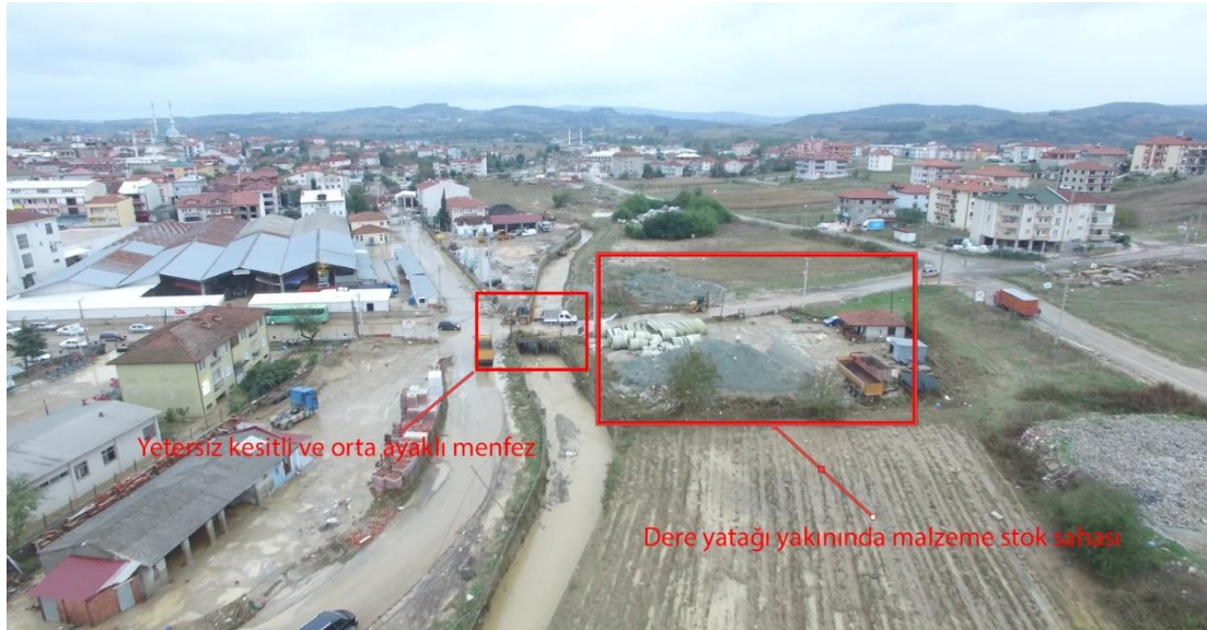
Şekil 2.2. Sakarya, Kaynarca, Seyren deresinde yetersiz kesitli geçiş yapısı ve uygusuz stok sahası
