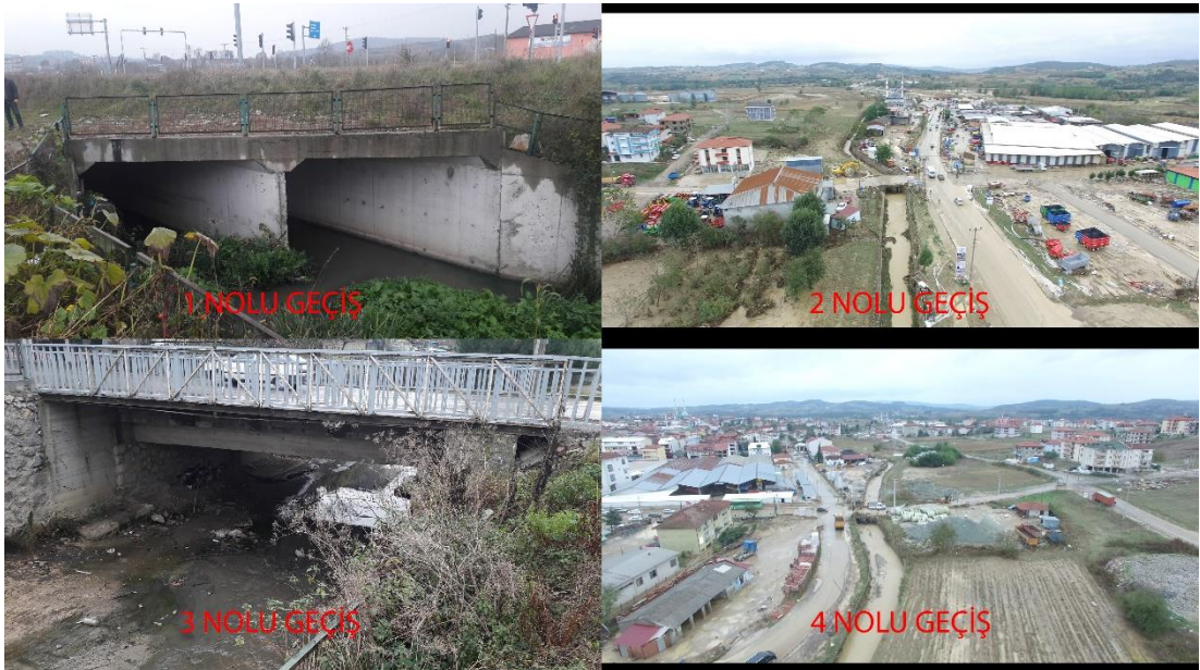
Şekil 5.8. Kaynarca ilçe merkezinde Seyren deresi üzerindeki 1,2,3 ve 4 nolu geçiş yapıları
