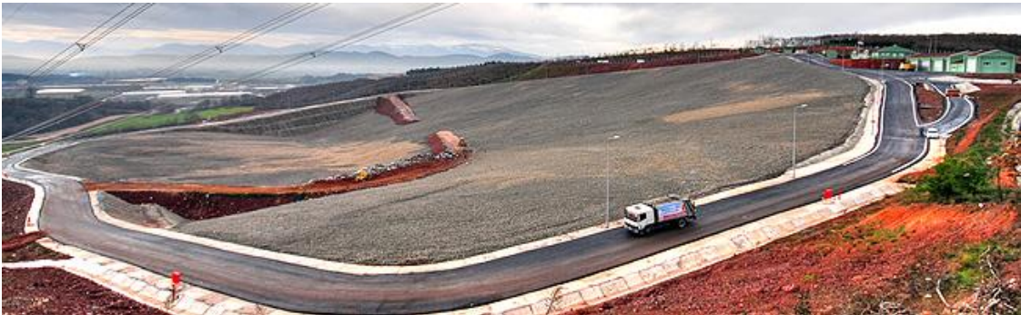
Şekil 56: Sakarya Katı Atık Düzenli Depolama Tesisi Fotoğrafi
