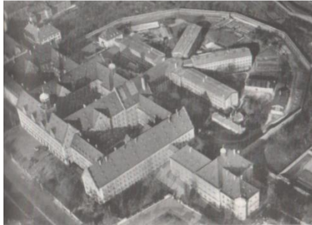
Fotoğraf 1: Nürnberg Askeri Ceza Mahkemesi Binası (Urban, 2008, s. 13).
