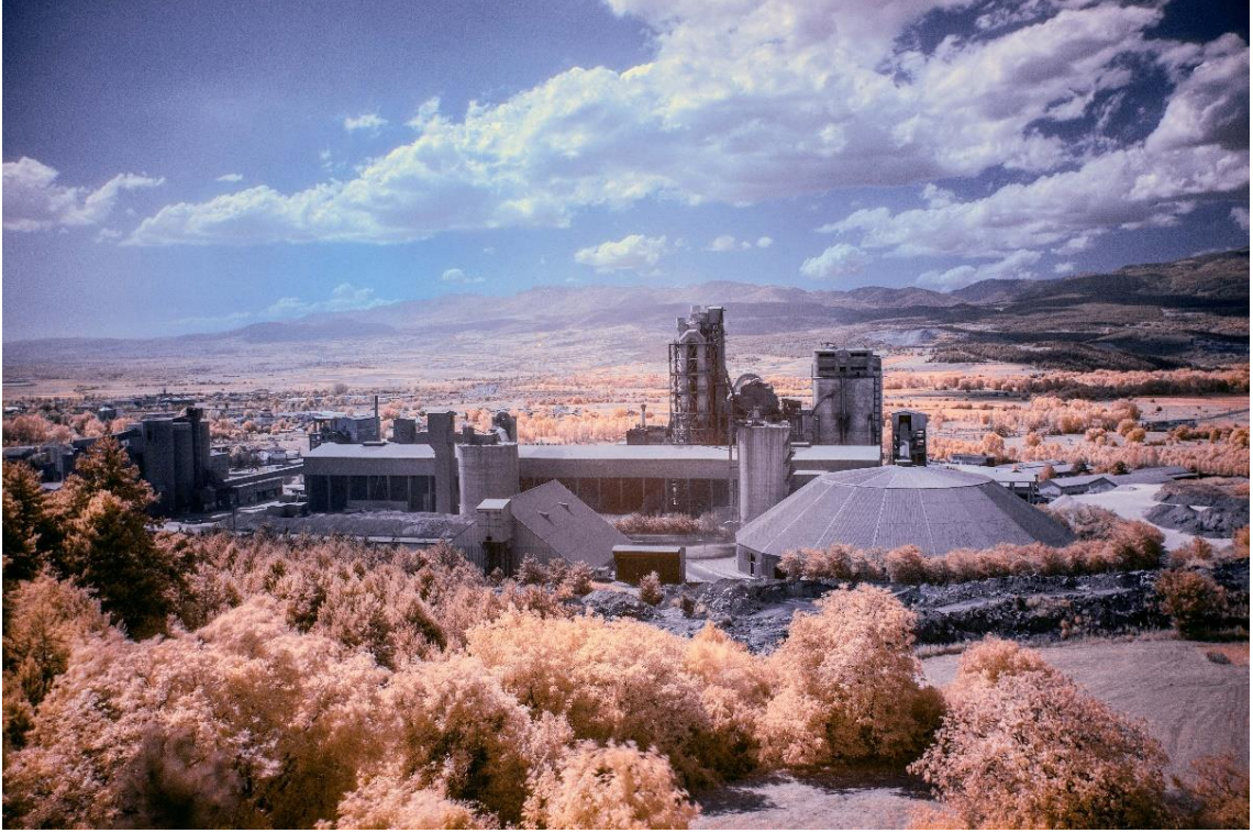
Görsel 71: Mahmut Rıfki Ünal, Çimento Fabrikası, Bolu (2020)
