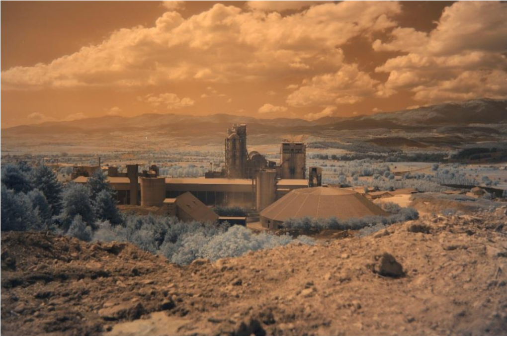
Görsel 64: Mahmut Rıfki Ünal, Çimento Fabrikası, Bolu (2020)
