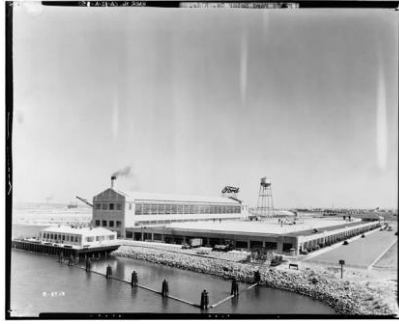
Resim 16: Ford Motor Company Long Beach Üretim Tesisi (1936)
