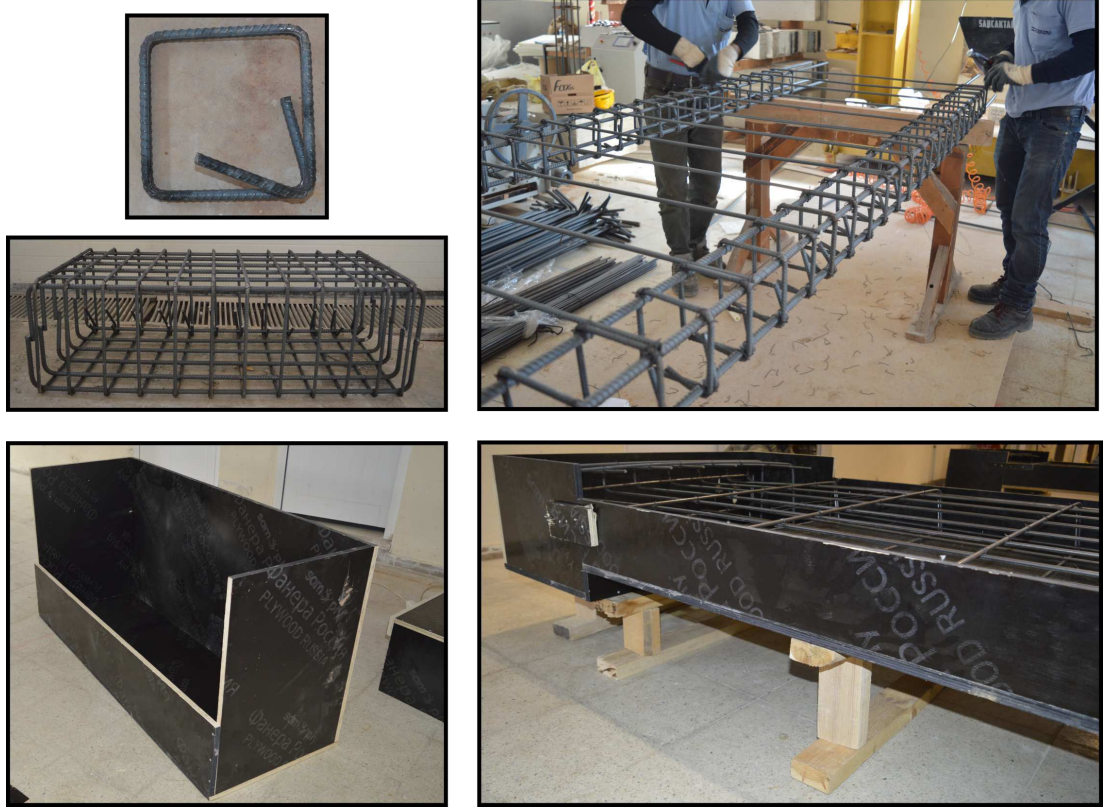
Şekil 3.2. Numunelerinin imalatı
