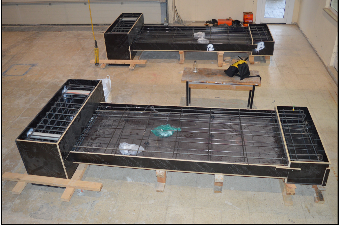
Şekil 3.12. Beton döküm işlemine hazır deney numuneleri
