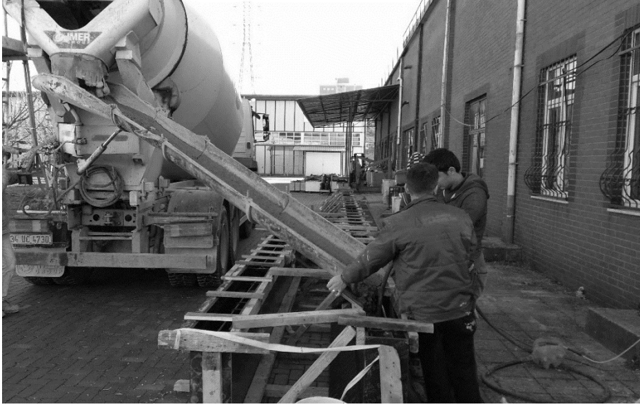
Şekil 16. Betonun kalıba yerleştirilmesi.
