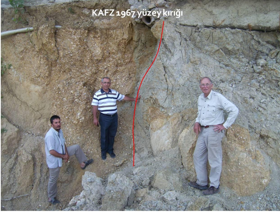
Şekil 28 Taşkesti Beldesi eski Jandarma Karakolu altında KAFZ 1967 yüzey kırığı ve Taşkesti formasyonu'nun ilişkisi.
