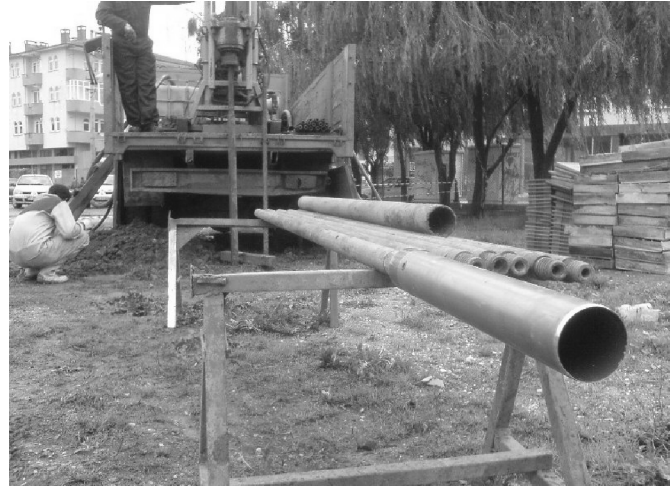
Şekil 4.1 Adapazarı'nda örselenmemiş numune elde edilmesi için 71.2 mm iç çapında Shelby tüp kullanılmıştır (ASTM, 2008)
