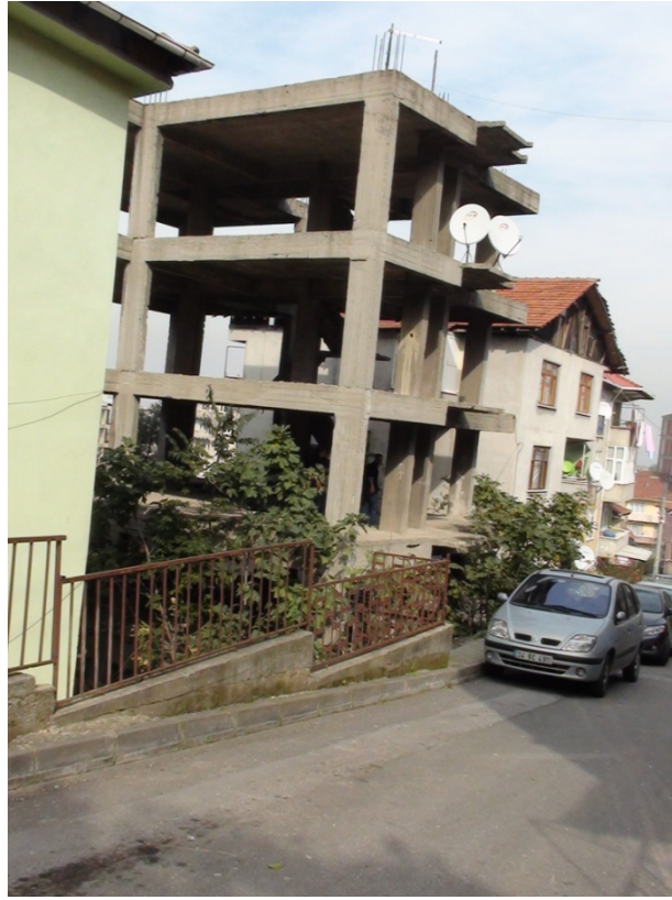
Şekil 6.27 Kalibrasyon analizlerinde kullanılan Hikmet Binası'nın genel görünüşü
