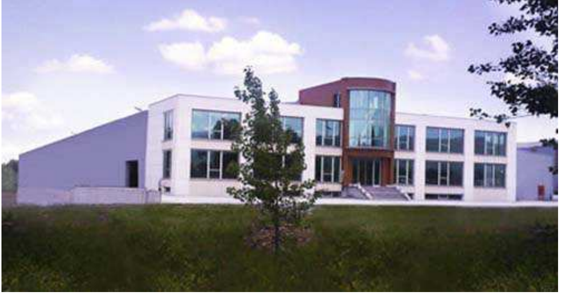
Figür 3.3: Türedi Tank İmalat Fabrika Binası Tamamlanmış Haliyle Resmi
