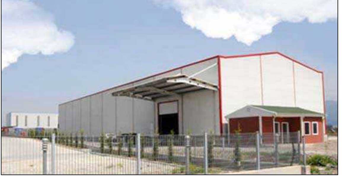
Figür 3.6: Özmen Gıda Fabrika Binası Tamamlanmış Haliyle Resmi
