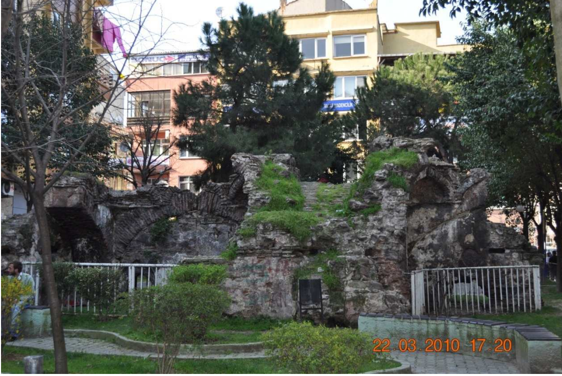
Resim 90: Hamam Kalıntısı- Güney Cephe
