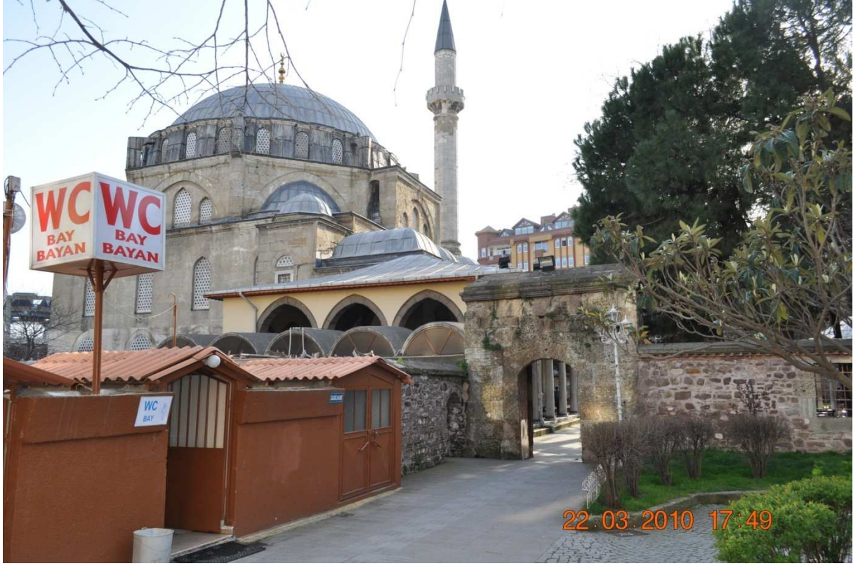
Resim 37 : İzmit Pertev Paşa Camii Avlu Duvarı-Doğu Avlu Kapısı ve Tuvalet Ünitesi- Doğu Cephe
