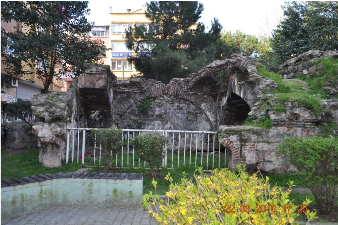
Resim 91: Hamam Kalıntısı- Güney Cephe
