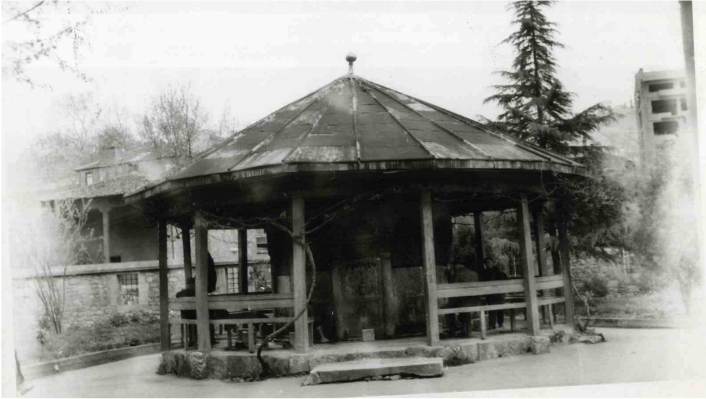
Resim 16: Şadırvan- Onarımdan Önce- Tarihi belli değil- (Vakıflar Genel Müdürlüğü)
