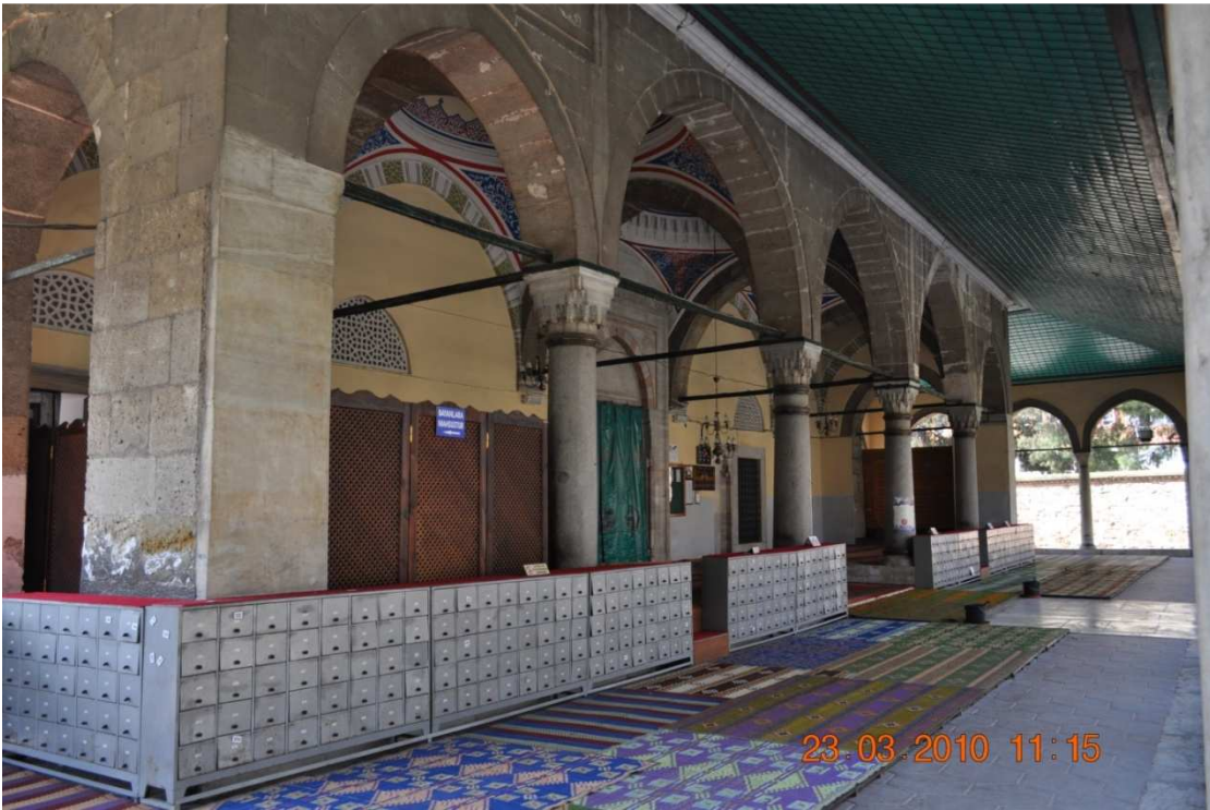
Resim 53 : İzmit Pertev Paşa Camii -Son Cemaat Yeri- İç Revak
