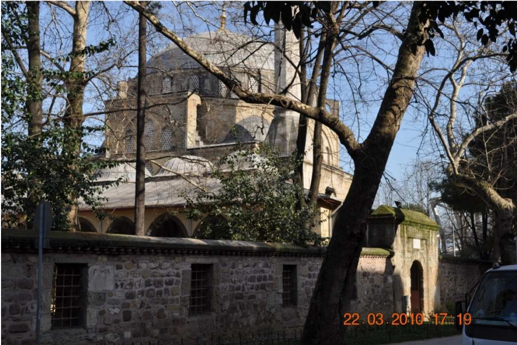
Resim 30 : Avlu Duvarı- Batı Cephe
