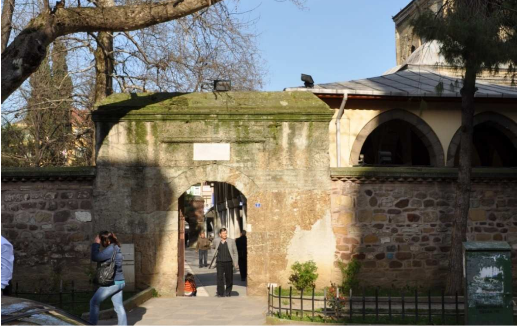
Resim 31: Avlu Duvarı- Batı Cephe- Batı Avlu Kapısı
