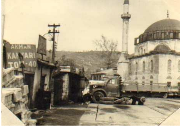
Resim 9: İzmit Pertev Paşa Camii Genel Görünüşü Güneybatı Cephe-1968 (Kocaeli Kültür ve Tabiat Varlıklarını Koruma Bölge Müdürlüğü)
