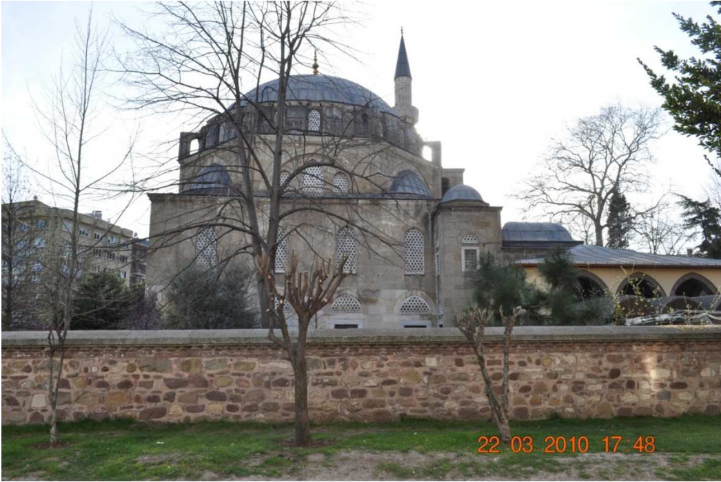
Resim 36 : İzmit Pertev Paşa Camii Avlu Duvarı- Doğu Cephe
