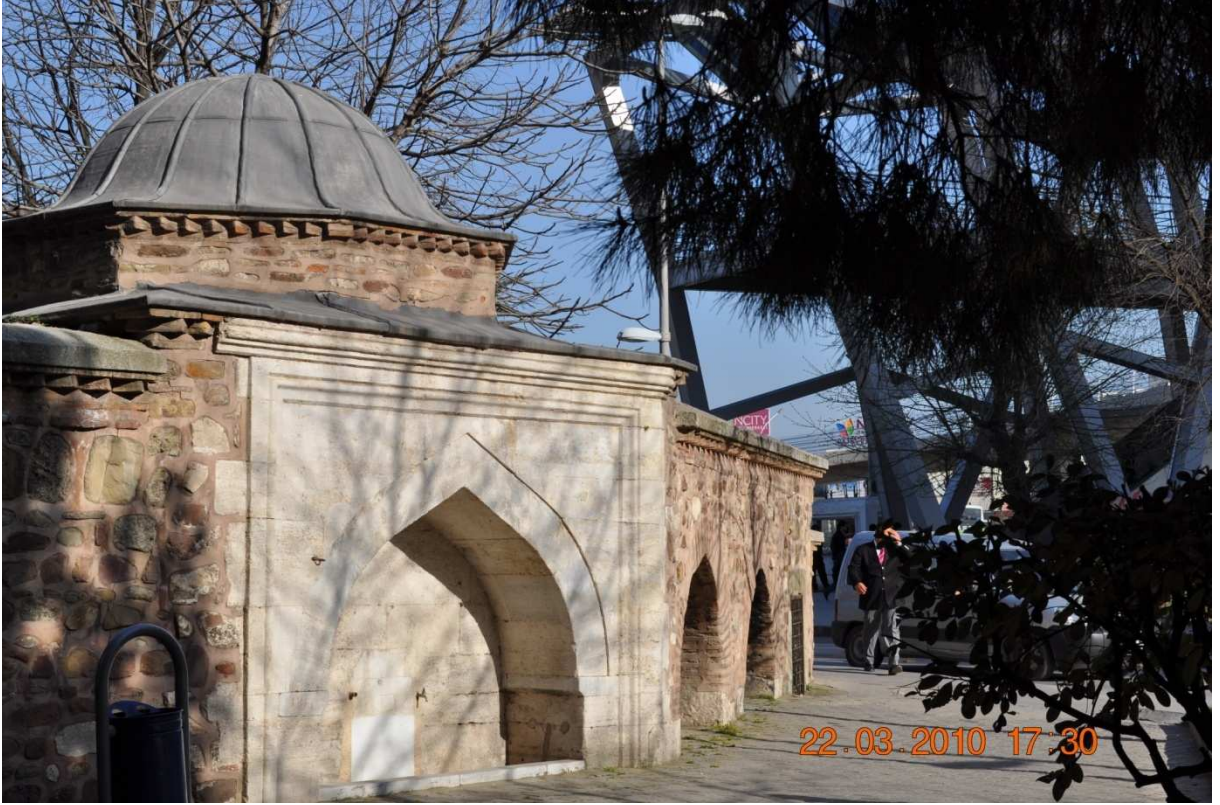
Resim 33 : Çeşme- Avlu Duvarı Güneybatı Cephe
