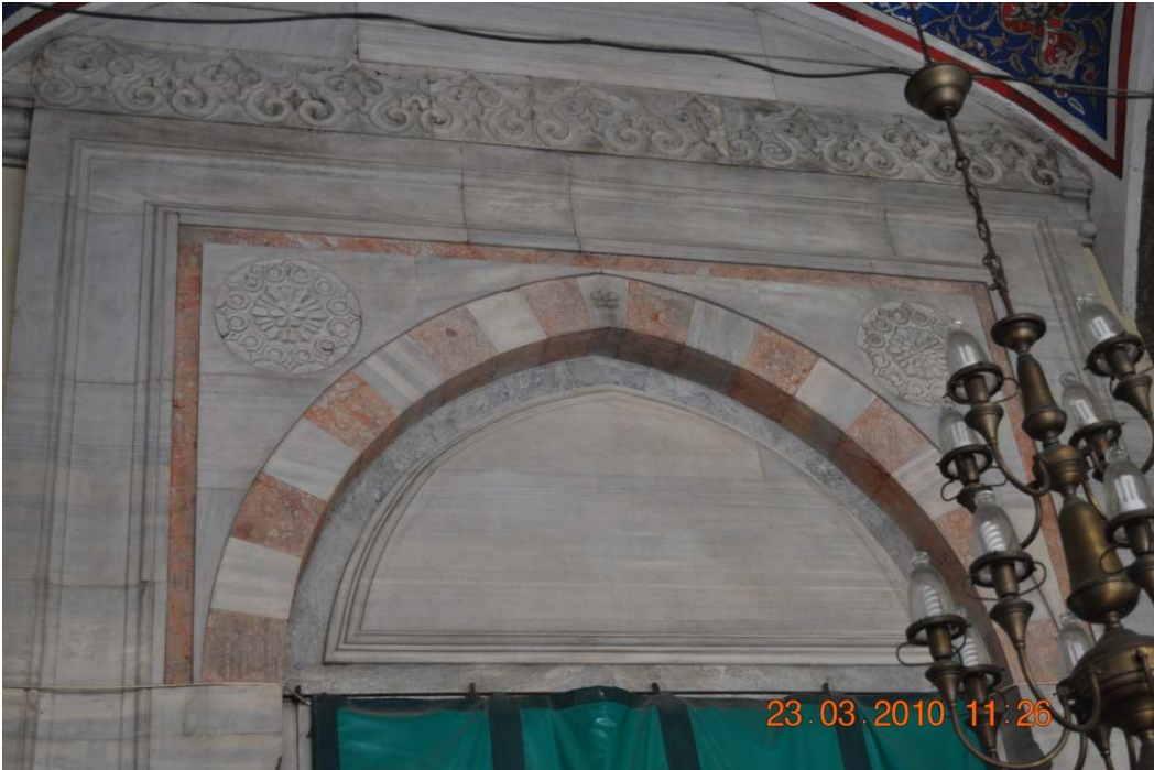
Resim 63: Camii Giriş Kapısı-Detay
