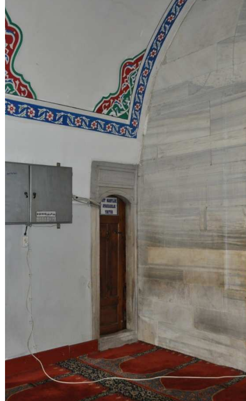
Resim 73: Kuzey Cephe-Mahfile çıkan merdiven kapısı
