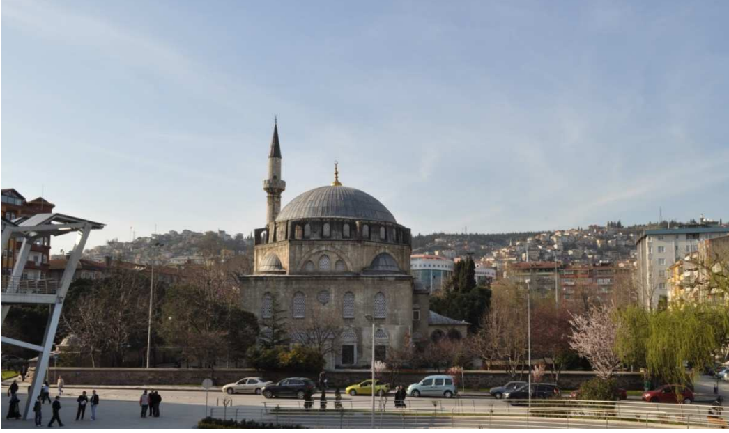
Resim 35 : İzmit Pertev Paşa Camii Avlu Duvarı- Güney Cephe
