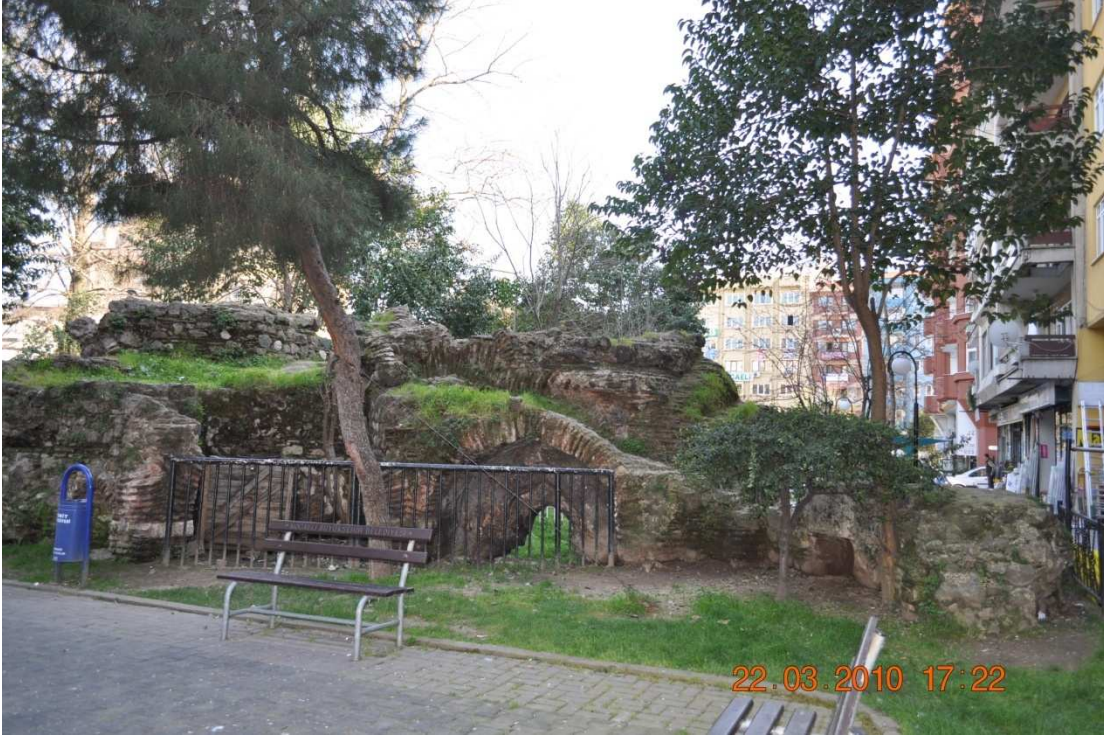
Resim 92: Hamam Kalıntısı- Kuzey Cephe
