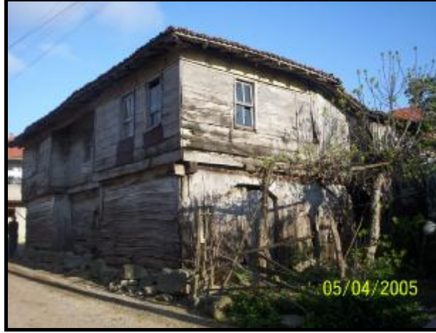
Şekil 57. Örme ev olarak inşa edilip bir bölümü yöredeki eski ocaklarda üretilen tuğlalar ile tadilata uğramış mesken
