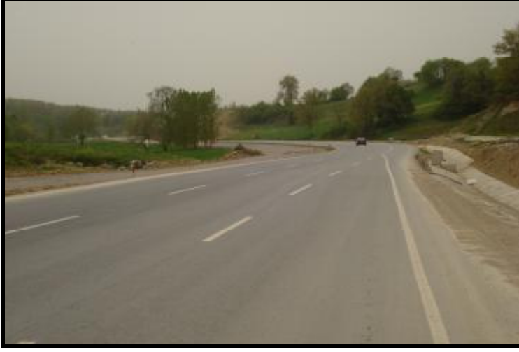
Şekil 95. İnşası süren Adapazarı- Kaynarca duble (bölünmüş) yolu
