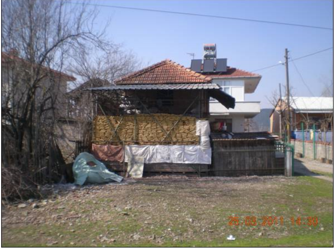
Şekil 14: Süleymanbey Mahallesi'ndeki Mısır Serenderi
