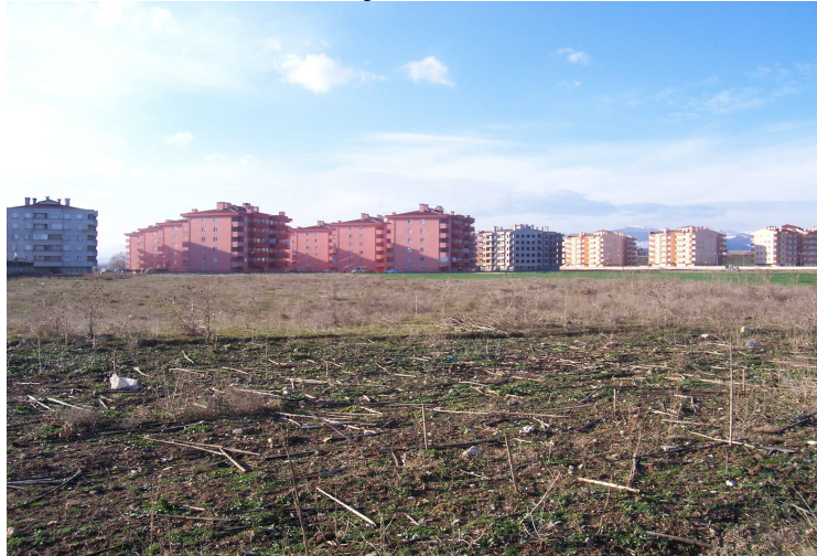
Şekil 39. Ataşehir, Atakent ve Gülbahçeşehir Siteleri, Şubat 2008
