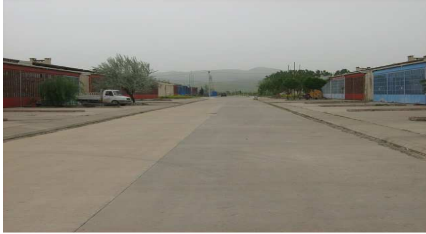
Şekil 59. Yeni Sanayi Sitesi Metal İşleri Bölümü, Mart 2008
