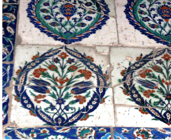
Resim 304: Sultan Ahmet Camii, üst kat ikinci açıklık üst duvarlarında bulunan şemseli pano
