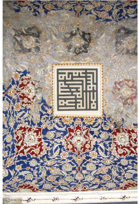
Resim 11: Restorasyon sonrası revak tonozu.
