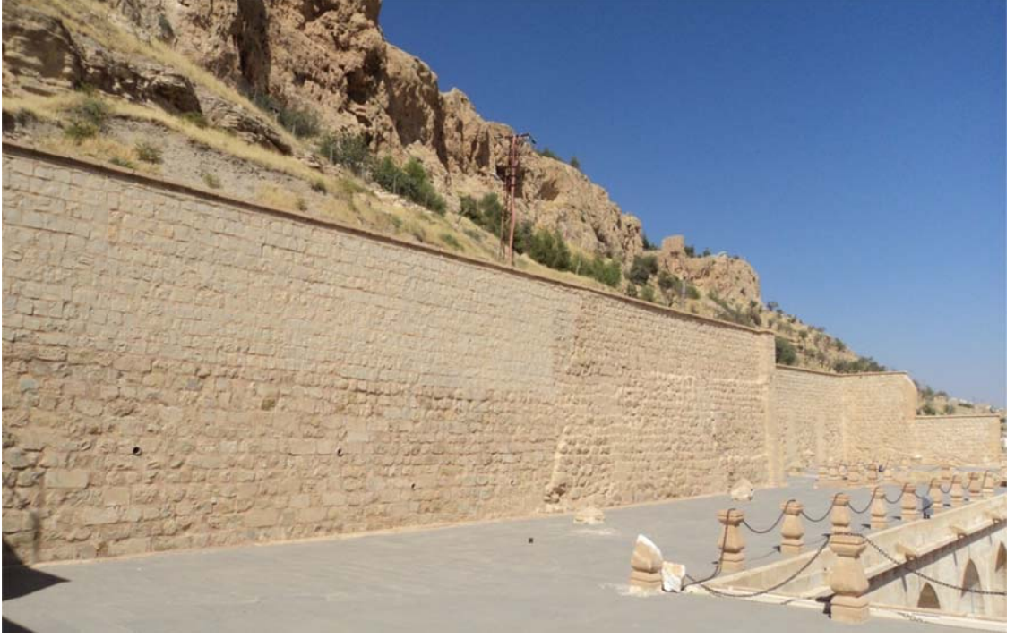
Fotoğraf 23: Zinciriye Medresesinin Kuzey Cephesindeki İstinat Duvarı
