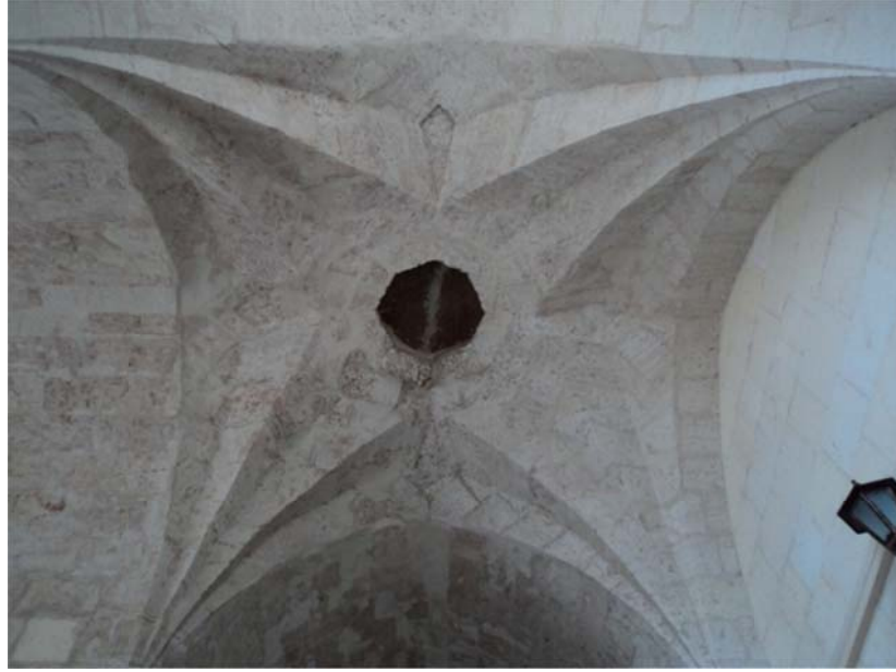
Fotoğraf 33: Giriş Koridoru İle Cami Girişinin Yer Aldığı Uzun Koridorun Kesiştiği Yerdeki Yıldızlı Tonoz.
