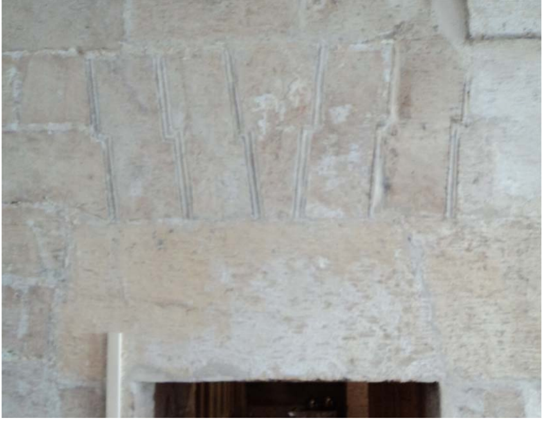
Fotoğraf 110: Zemin Kat Avlusunun Kuzey Doğusundaki Odanın Kapı Atkı Taşının Yukarısında
