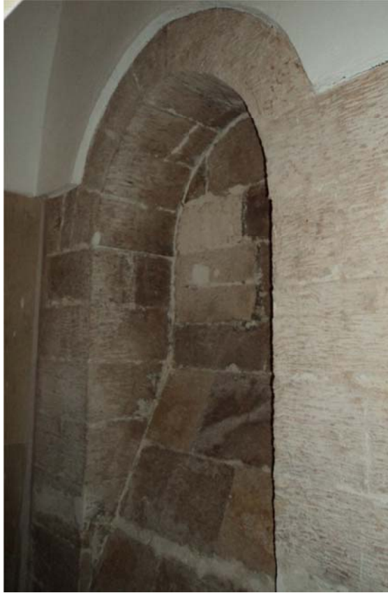
Fotoğraf 76: Medresenin Tuvalet İhtiyacını Karşılamanın Bölümünün Kuzey Cephesindeki Niş
