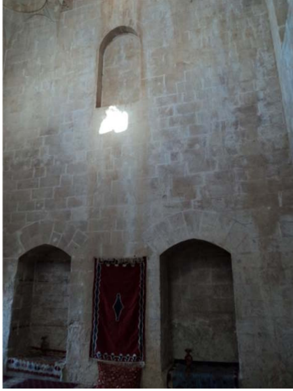
Fotoğraf 56: Zinciriyе Medresesinin Türbe Mescidinin Batı Cephesi
