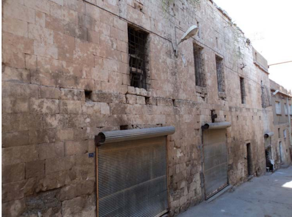
Fotoğraf 6: Savurkapı Medresesinin Güney Cephesi
