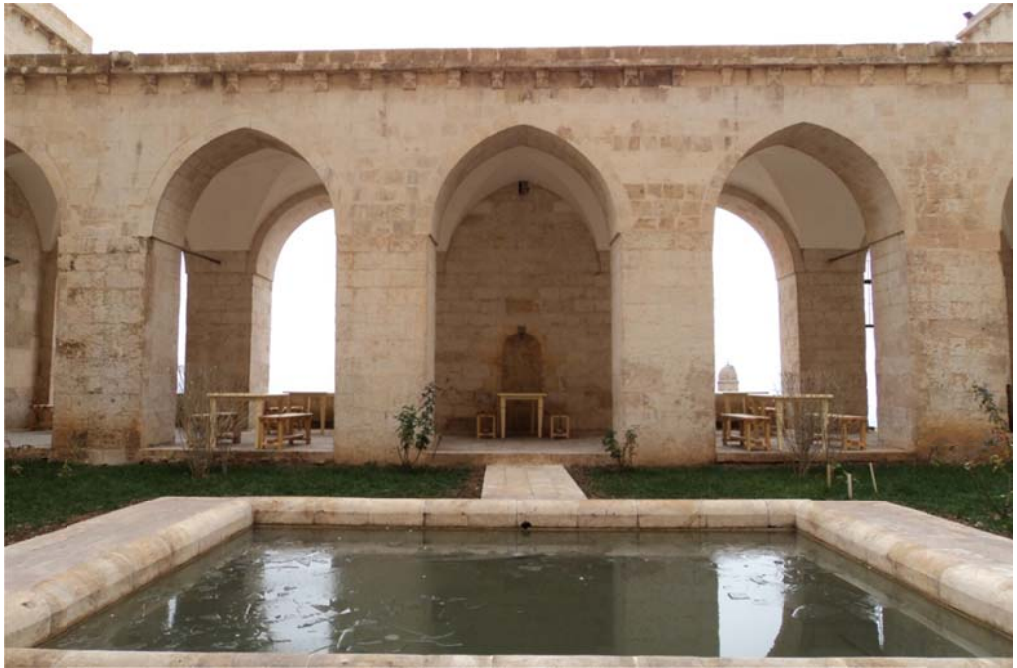
Fotoğraf 45: Zinciriye Medresesi Zemin Kat Avlusunun Güney Kanadındaki Revaklar
