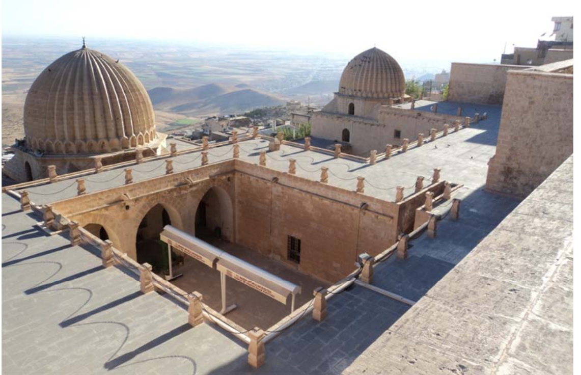
Fotoğraf 94: Medresenin İstinat Duvarından Dilimli Kubbelerin Görünüşü
