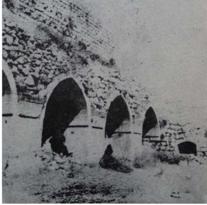
Fotoğraf 69: Üst Kat Doğu ve Batıdaki Mekânlarını Birleştiren Revakların Kuzey Cephesindeki Kemerli Nişlerin Restore Edilmeden Önceki Vaziyeti (Fot: Metin Sözen'den)
