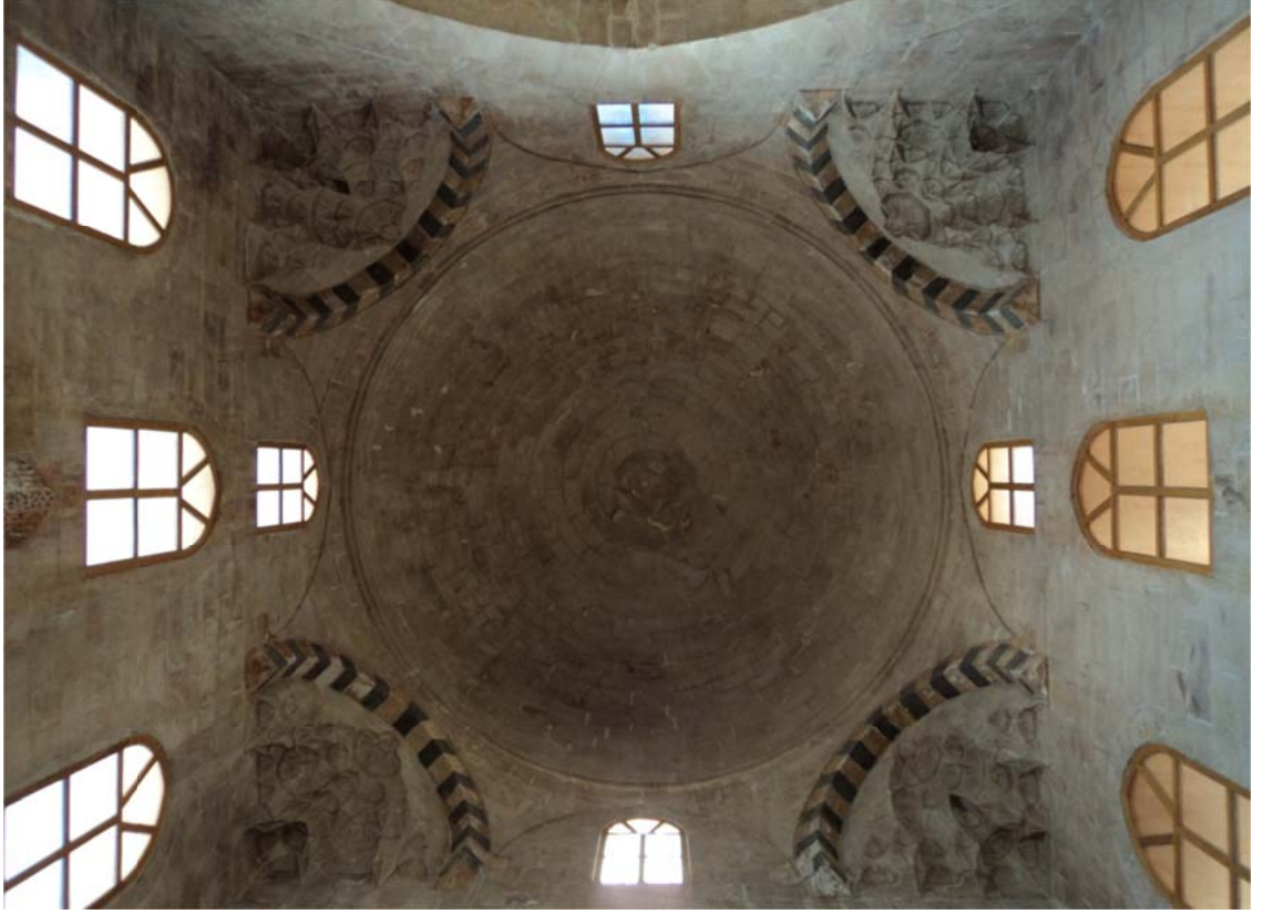
Fotoğraf 37: Cami Dilimli Kubbesinin İçten Görünüşü
