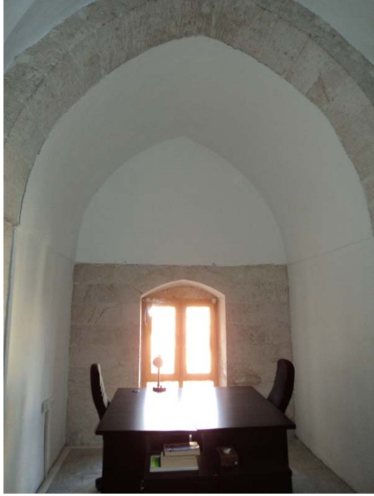
Fotoğraf 64: Üst Kat Türbe Mescidinin Kuzeyindeki Bölümün Doğu Cephesindeki Beşik Tonozlu Alan
