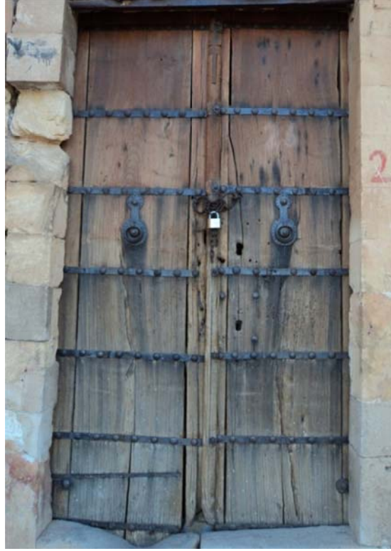
Fotoğraf 92: Mardin Zinciriye Medresesinin Ahşaptan Yapılmış Kapı Kanatları
