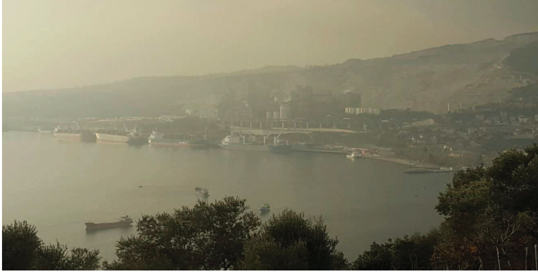
Fotoğraf 4 : Nuh Çimento Fabrikası
