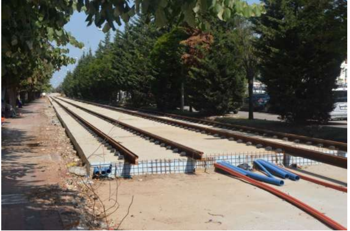
Foto 24: Valilik Mevkiindeki Akçaray Tramvay Çalışması
