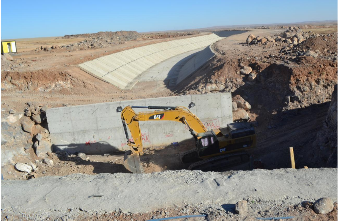
Şekil 10: Suruç Sulama Projesi Su Kanalı Yapım Çalışması
