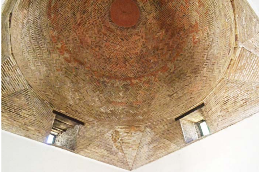
Resim 114: Türbe Bölümü Kubbesi Tuğla İşçiliği
