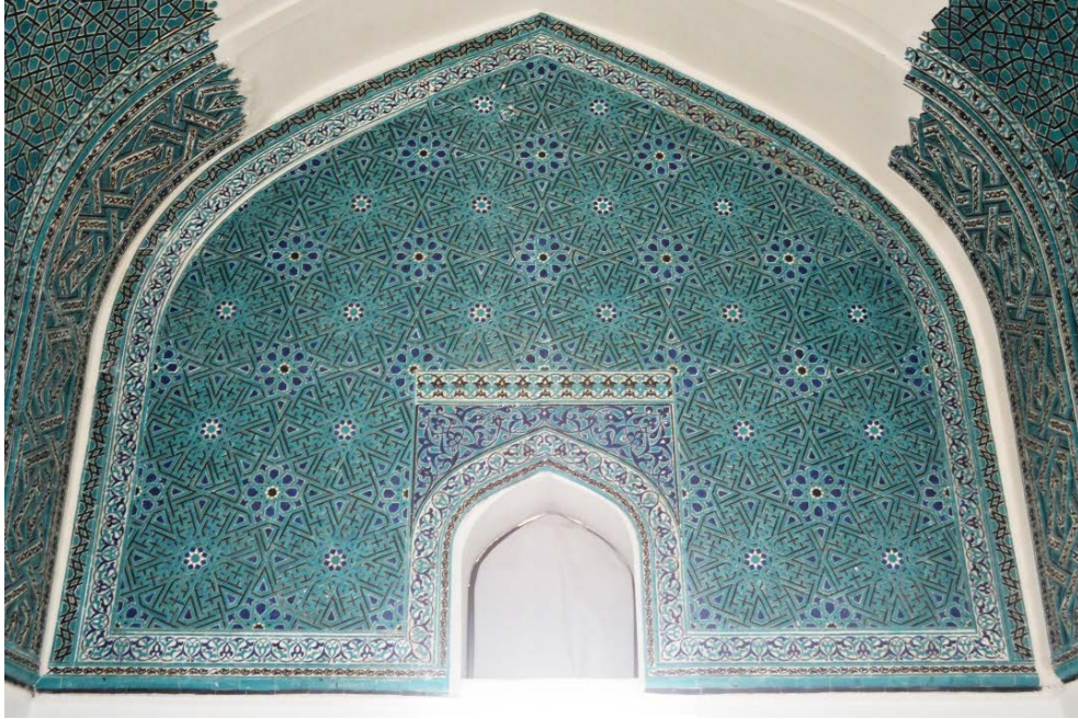
Resim 127: Eyvan Arka Duvarı
